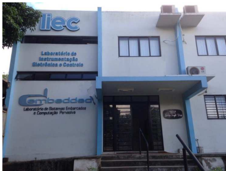
Figura 1: Foto da fachada do Laboratório
