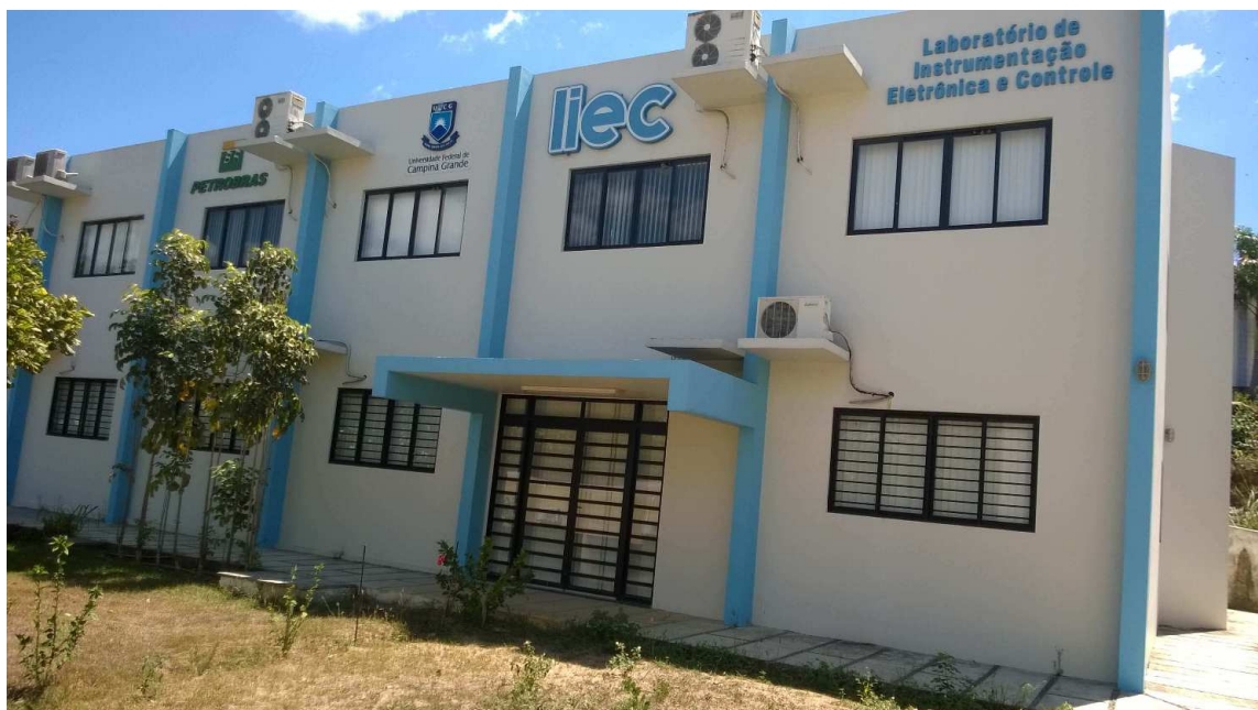
Figura 1 – Fachada do Laboratório de Instrumentação Eletrônica e Controle - LIEC (Fonte: http://liec.ufcg.edu.br/ ).
