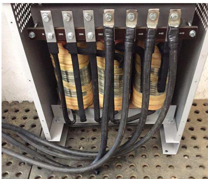
Figura 16-Instalação do transformador do umidificador.
