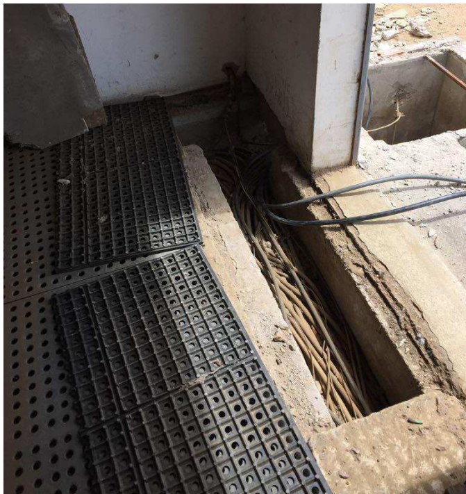
Figura 15-Passagem dos cabos dentro da subestação.
