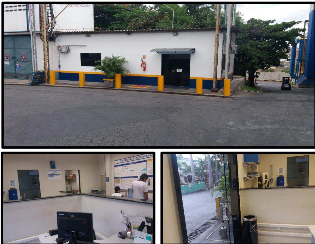
Figura 3 - Fotografia do Setor da Manutenção Elétrica
