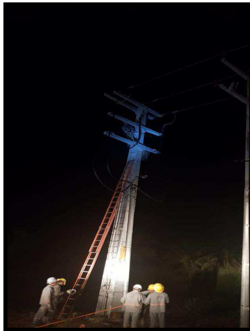
Figura 15 Inversão de Fases dos Cabos
