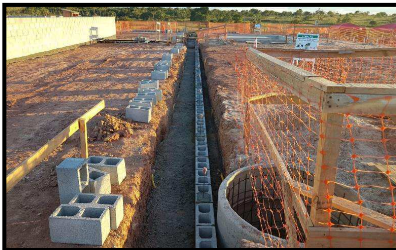
Figura 22 Alvenaria da Canaletas
