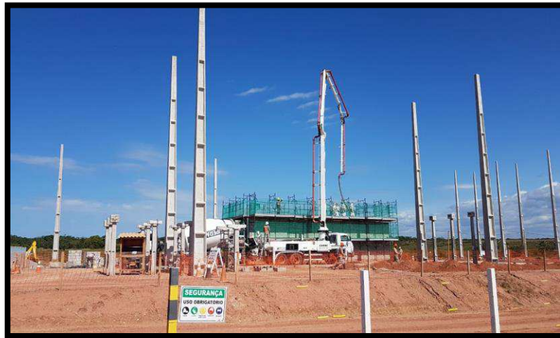
Figura 23 Aplicação de concreto na Laje da Casa de
