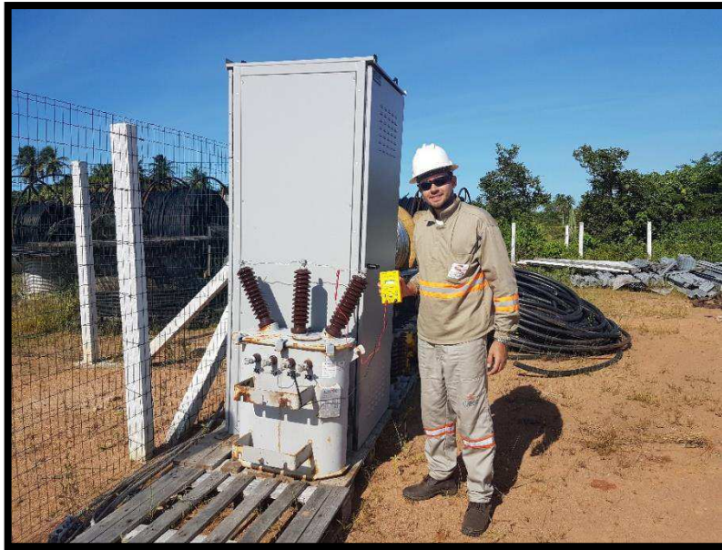
Figura 12 Realização do Teste de Isolação do Trafo
