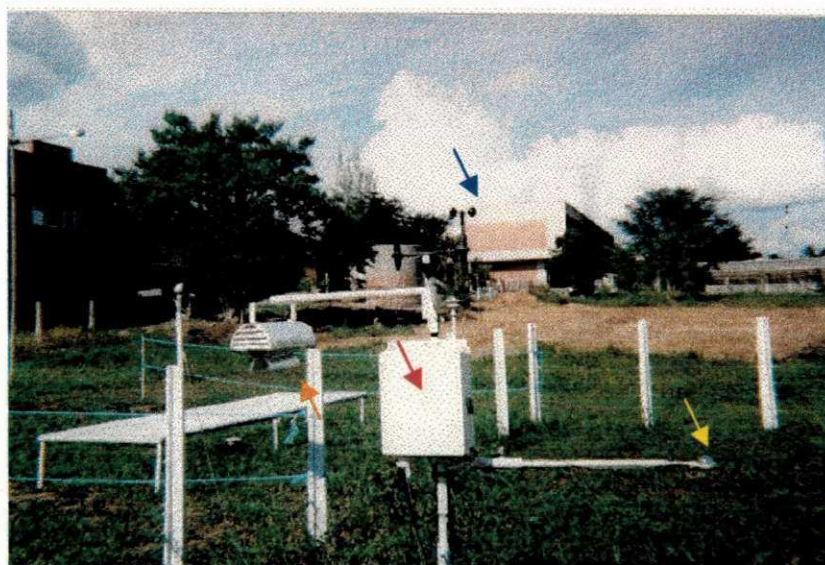
Figura 4 Sistema automático microloggers 21x de aquisição de dados (seta vermelha) e os sensores de umidade (seta laranja), temperatura do ar (seta laranja), velocidade do vento (seta azul) e saldo de radiação (seta amarela)
