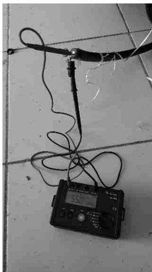
Figura 3.25 – Teste de isolamento dos cabos de entrada.
