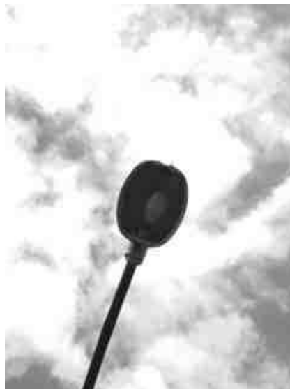
Figura 3.19 – Tipo de luminária nas ruas de Borborema-PB.
