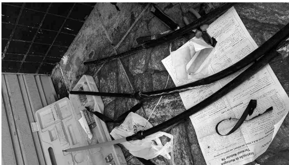
Figura 3.21 – Procedimentos de instalação das muflas externas.
