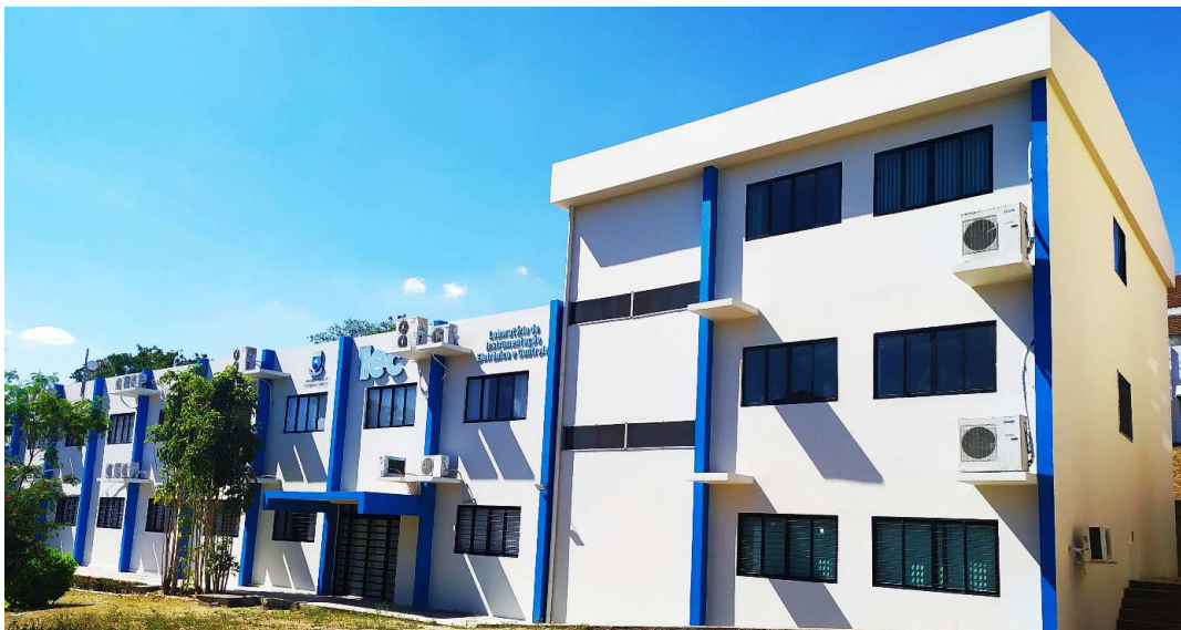
Figura 1 – Fachada do LIEC.
