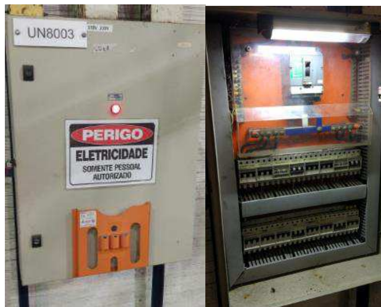
Figura 11 – Adequação Painel UN08003
