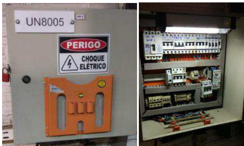
Figura 12 – Adequação Painel UN08005
