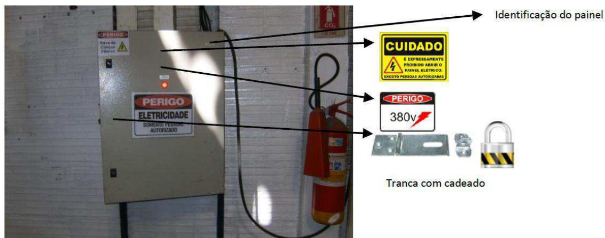
Figura 05 – Painel UN08003 (Vista exterior)
