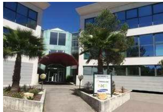
Fig. 2. Fachada do local de estágio.
