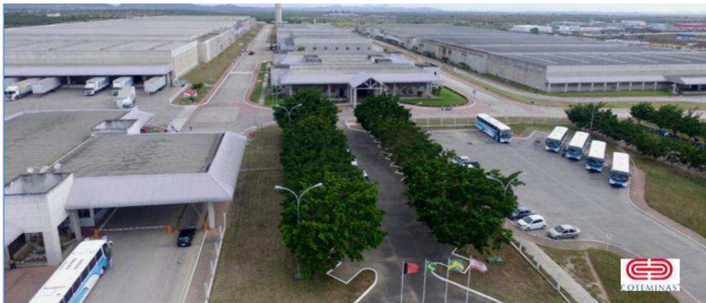
Figura 1 – Coteminas unidade Campina Grande.
