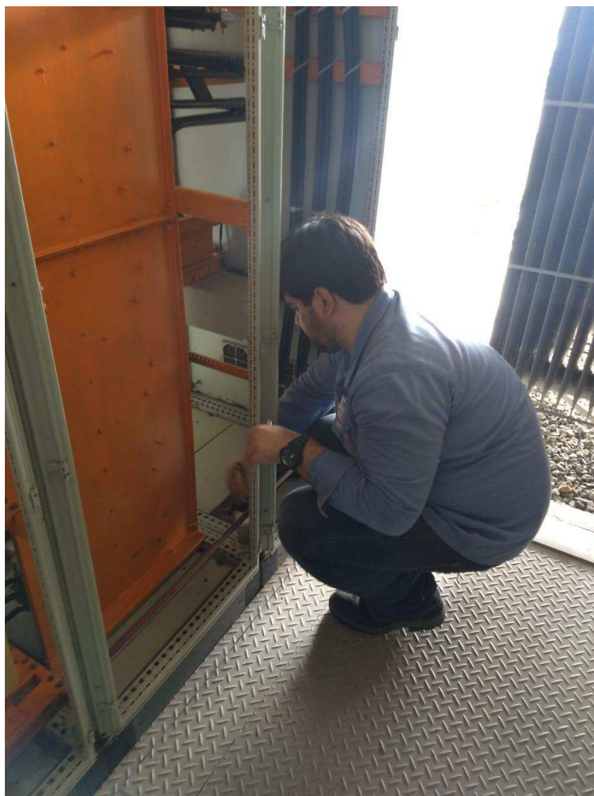
Figura 10 - Limpeza do quadro de força da subestação 3.0 Embratex.
