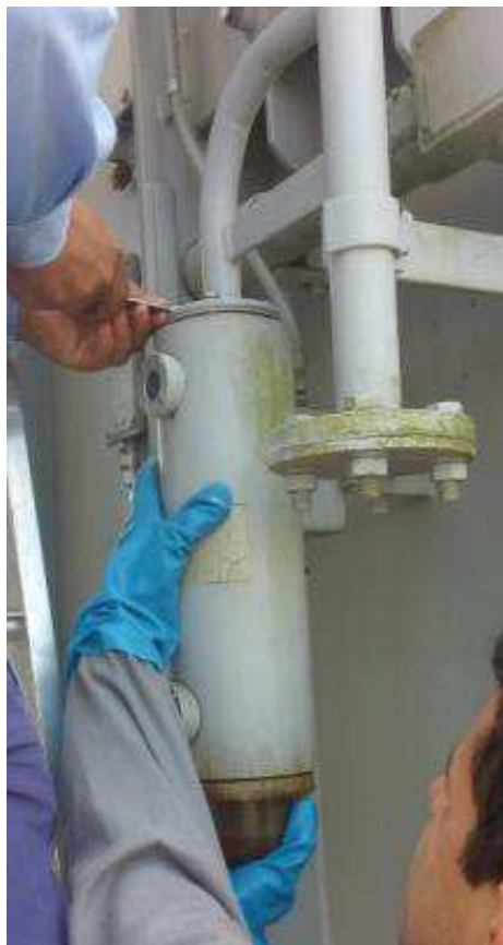
Figura 13 – Remoção do desumidificador de ar do transformador.
