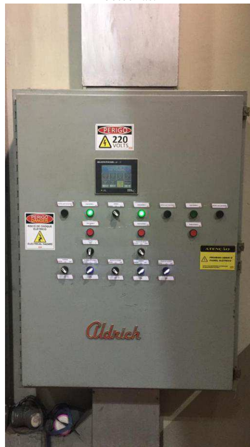
Figura 22 - Painel com substituição das botoeiras.
