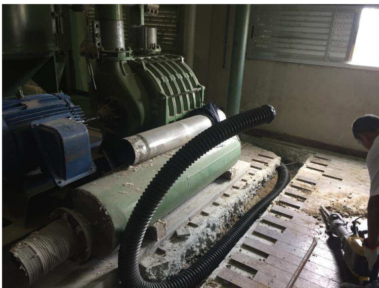
Figura 17 - Passagem do kanaflex enterrado.
