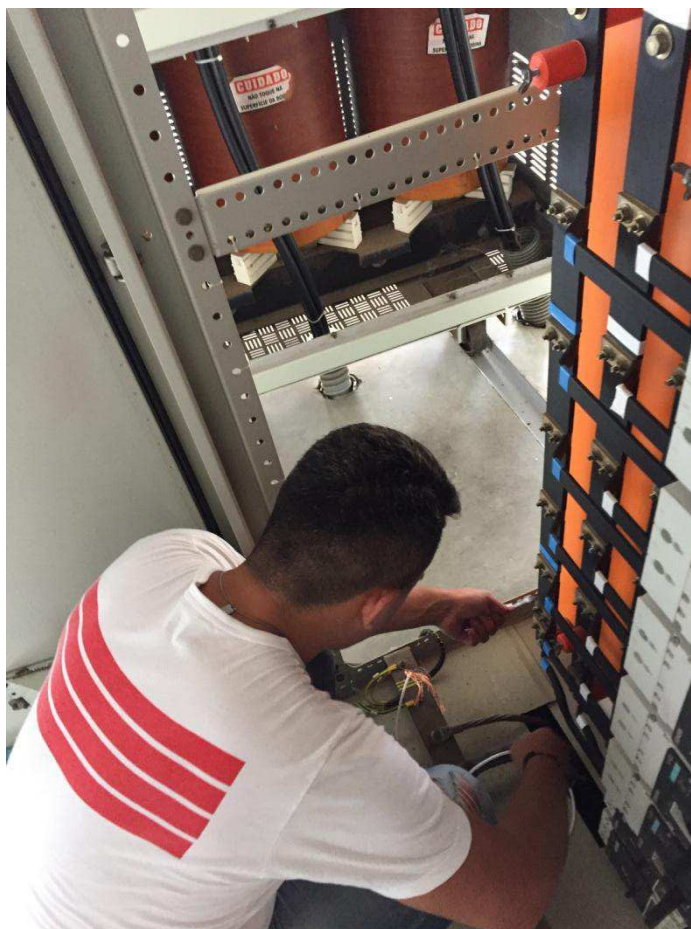
Figura 11 - Execução do aterramento de trabalho.
