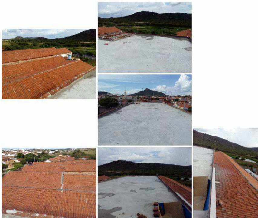
Figura 3.6: Fotos Tiradas da Cobertura de uma Fábrica, Malta-PB
