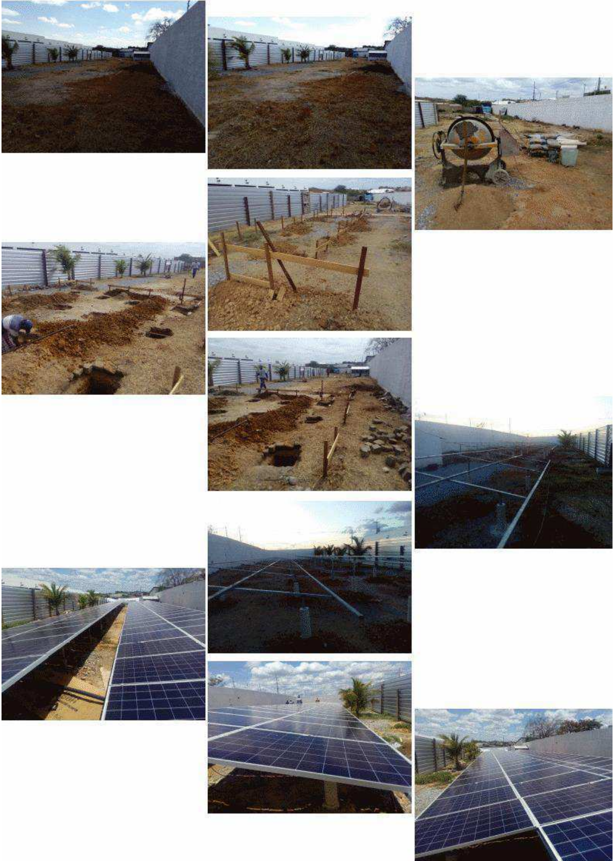
Figura 3.8: Registros da Evolução da Obra no Motel, Patos-PB
