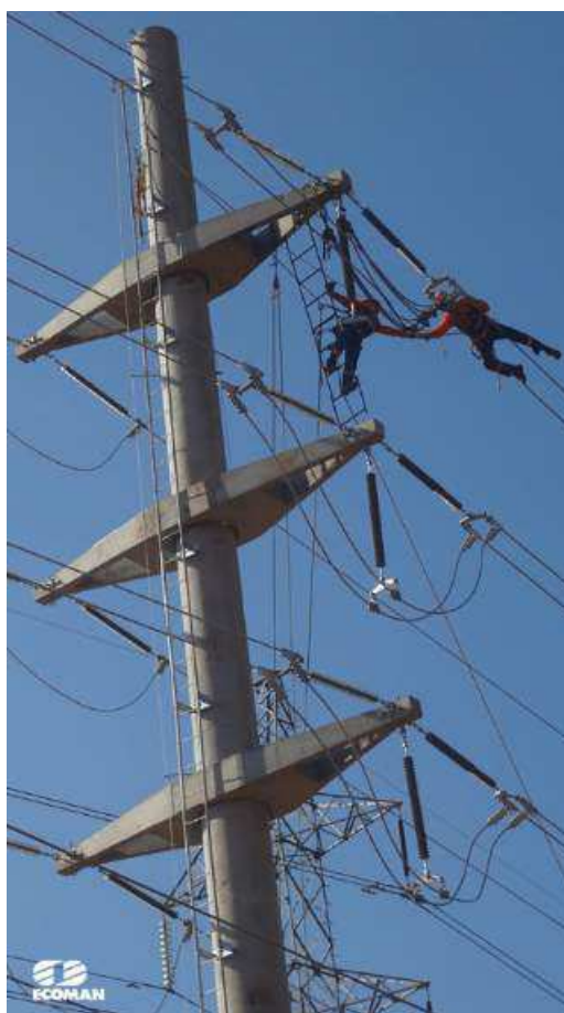
Figura 14 – Equipe Ecoman realizando serviços na LDAT 138 kV Várzea Grande-Poconé
