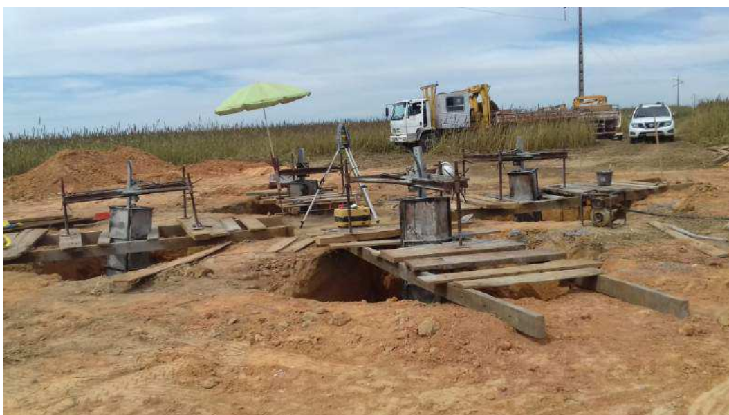
Figura 29 – Estrutura tipo ancoragem sendo concretada
