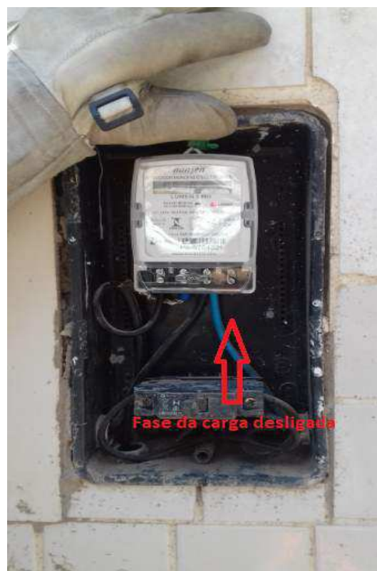
Figura 11 – (a) Corte no poste (b) Corte no medidor
