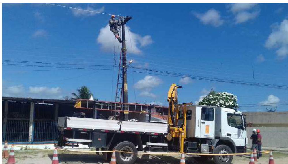
Figura 22 – Isolação da área para realização de parte da obra
