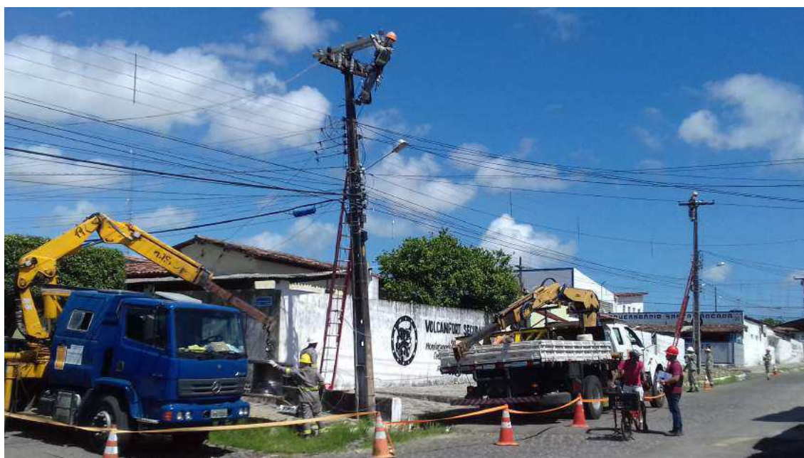
Figura 23 – Troca de cruzeta, isoladores tipo pino e lançamento de condutores na MT
