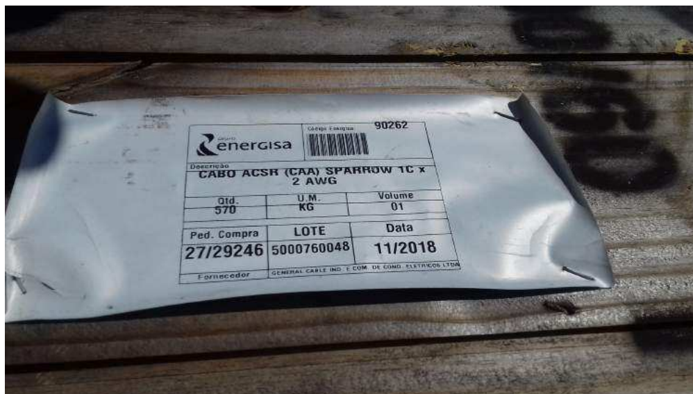
Figura 21 – Condutor utilizado na obra
