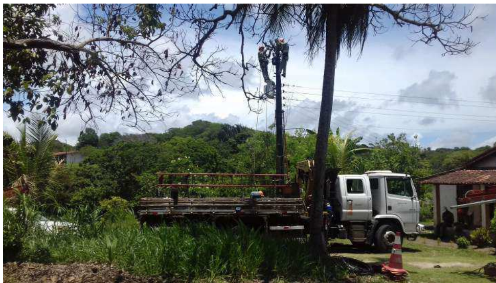
Figura 15 – Equipe DCMD Ecoman realizando a troca da cruzeta do poste
