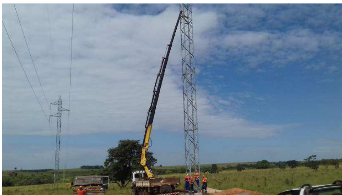
Figura 32 – Equipe fixando estrutura à base
