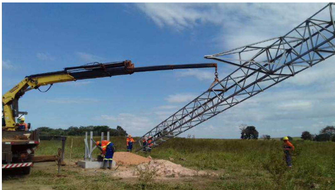
Figura 31 – Estrutura tipo suspensão sendo içada
