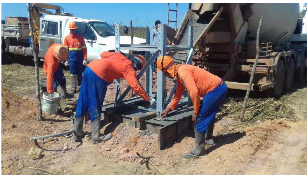
Figura 30 – Estrutura tipo suspensão recebendo concreto usinado
