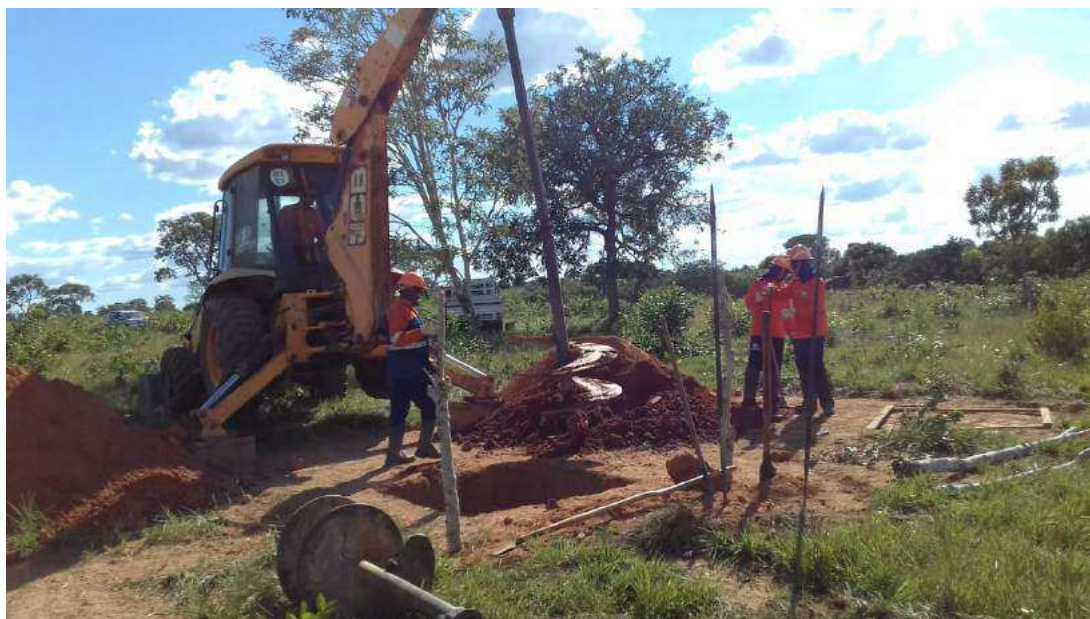
Figura 28 – Escavação de estrutura tipo suspensão
