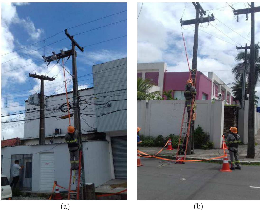
Figura 20 – (a) Corte sendo executado (b) Corte executado
