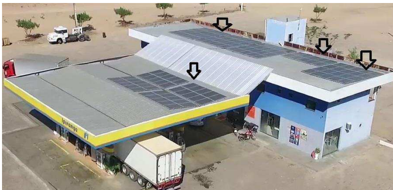
Figura 4: Vista aérea dos módulos.
