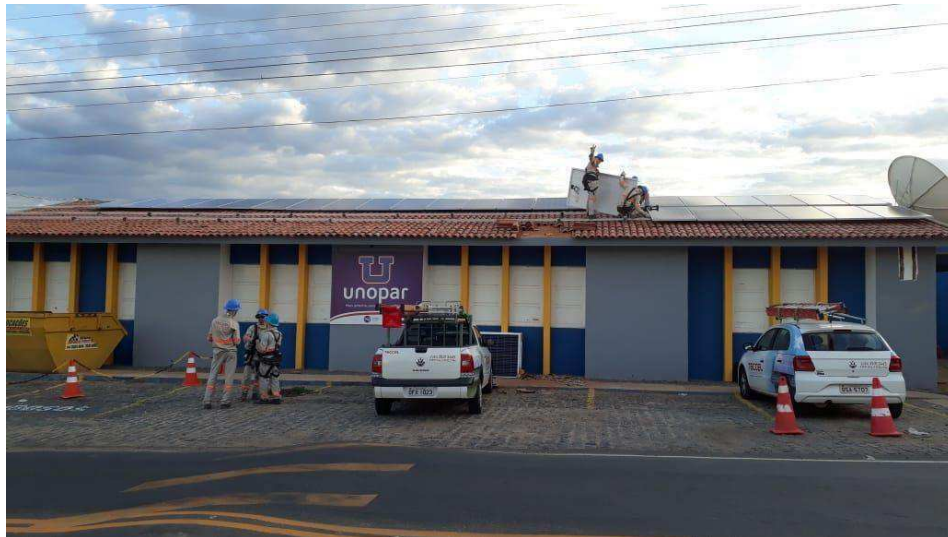
Figura 23 – Local de trabalho sinalizado
