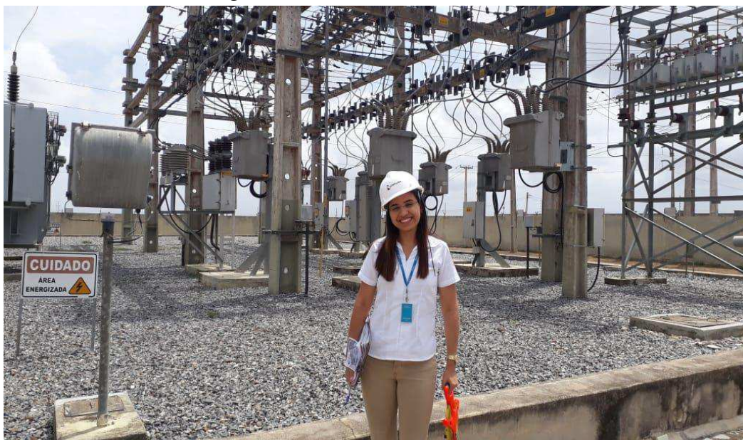
Figura 17 – Vistoria SE Alto Branco
