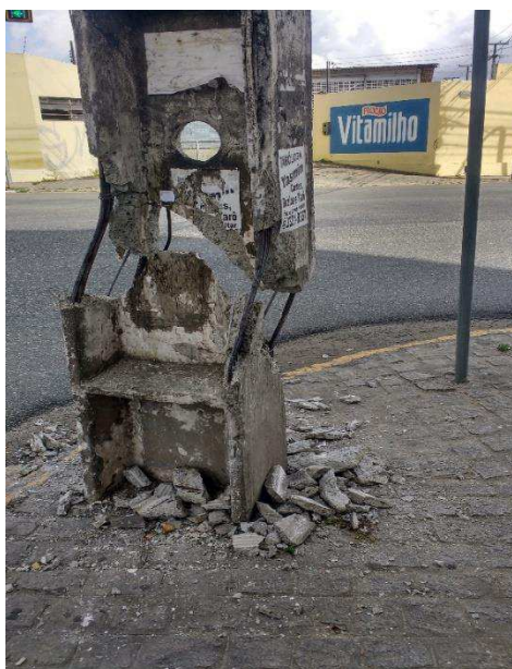
Figura 16 – Poste abalroado na Av. Assis Chateaubriand
