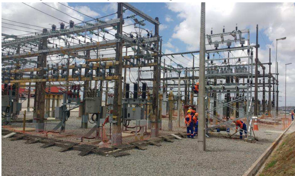
Figura 14 – Construção Banco de Capacitores – Barramento P1
