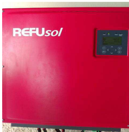
Figura 13 – Inversor de potência
