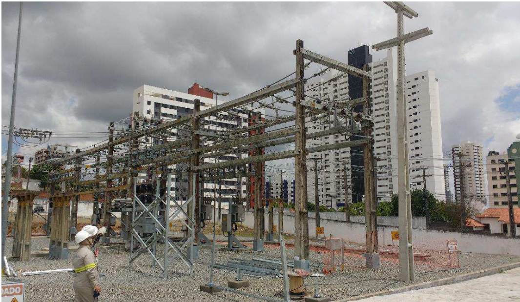
Figura 15 - Construção Banco de Capacitores – Barramento P2
