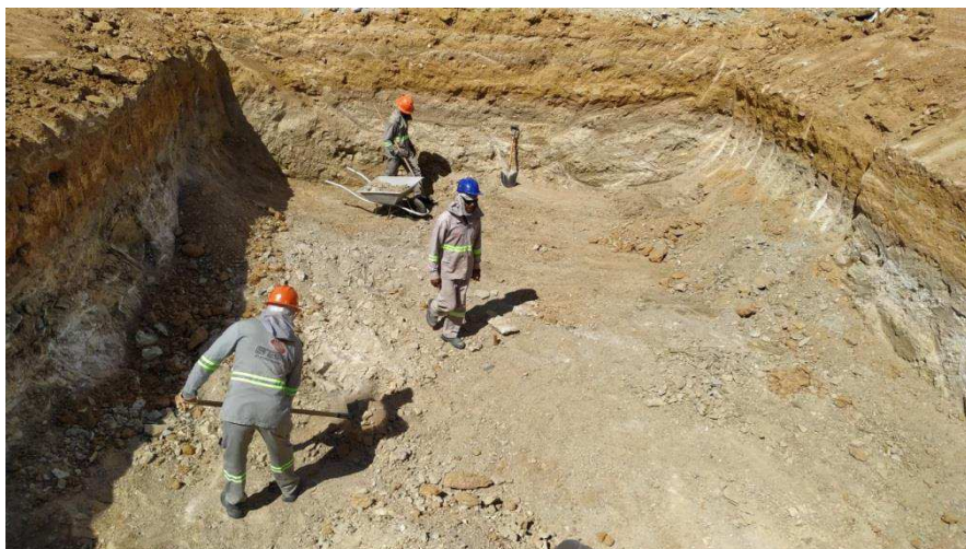
Figura 10 – Regularização da escavação da fundação de um pórtico.
