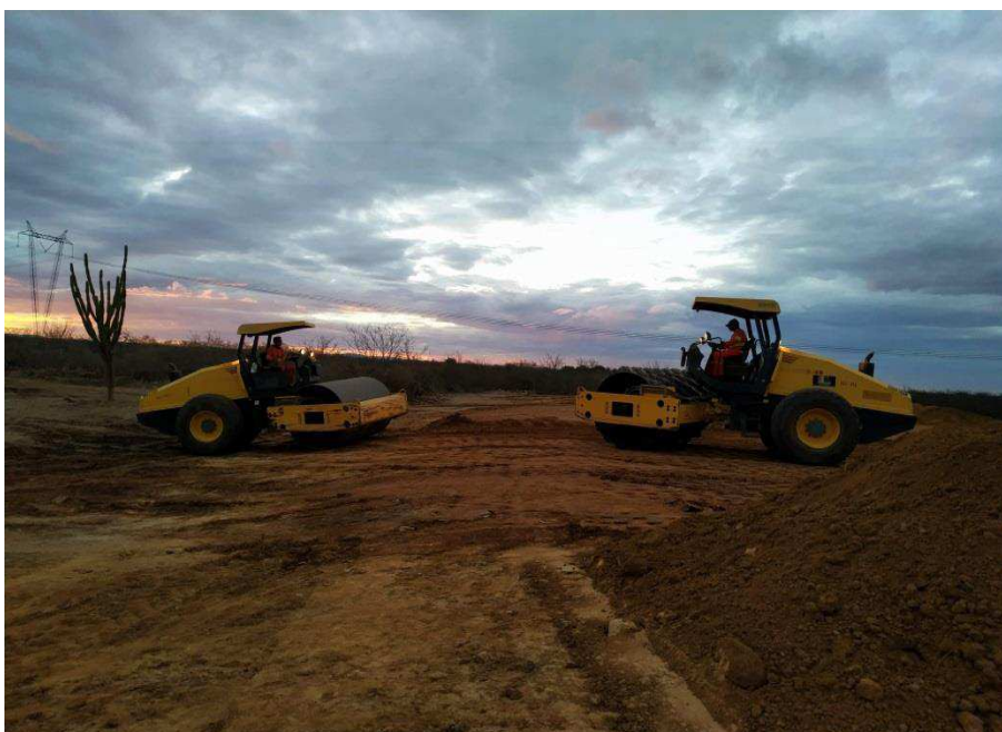
Figura 5 – Compactação de material de jazida.
