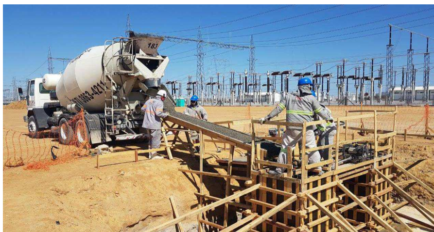
Figura 16 – Concretagem dos pilares da fundação de um pórtico.
