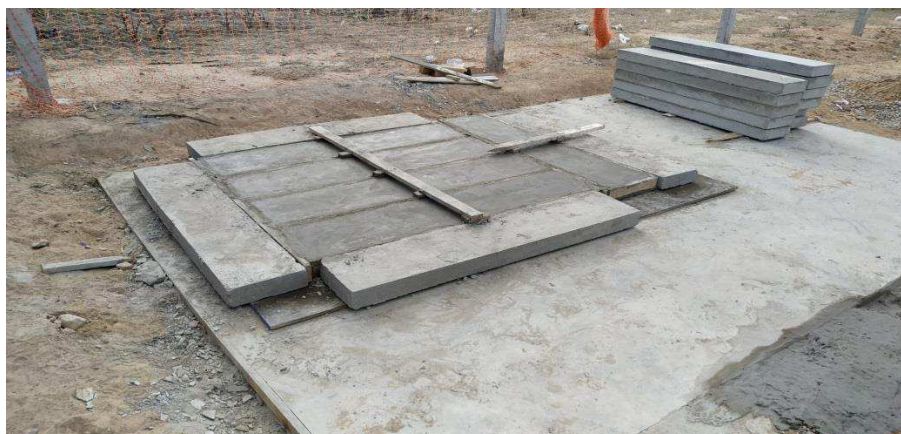
Figura 8 – Tampas das caixas de passagem.
