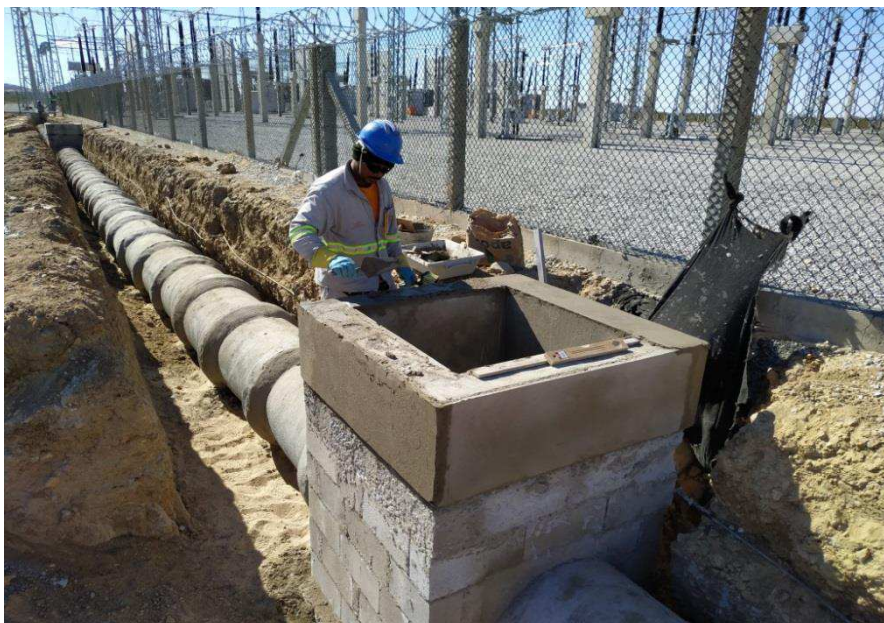
Figura 7 – Construção do sistema de drenagem periférico.
