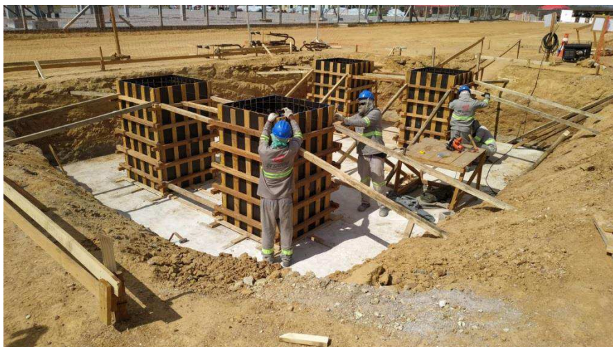
Figura 15 – Montagem das fôrmas dos pilares da fundação de um pórtico.
