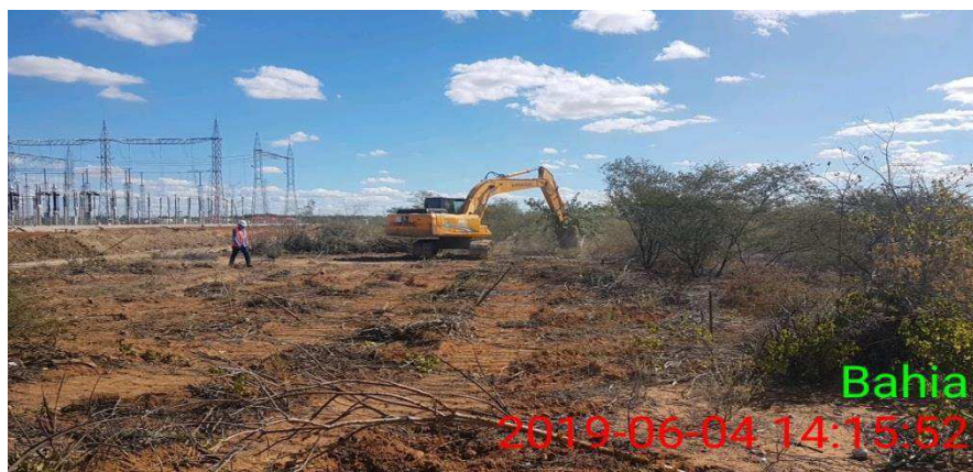
Figura 2 – Retirada da camada vegetal.
