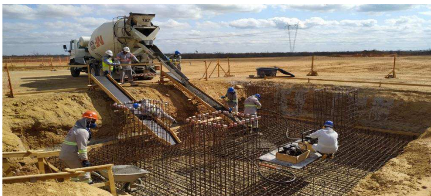
Figura 14 – Concretagem da sapata da fundação de um pórtico.
