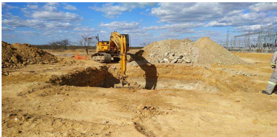
Figura 9 - Escavação da fundação de um pórtico.
