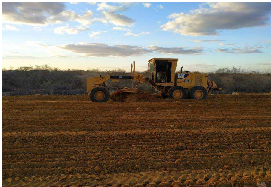
Figura 4 - Espalhamento de material de jazida.
