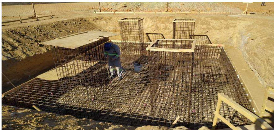
Figura 13 – Instalação das fôrmas da sapata da fundação de um pórtico.
