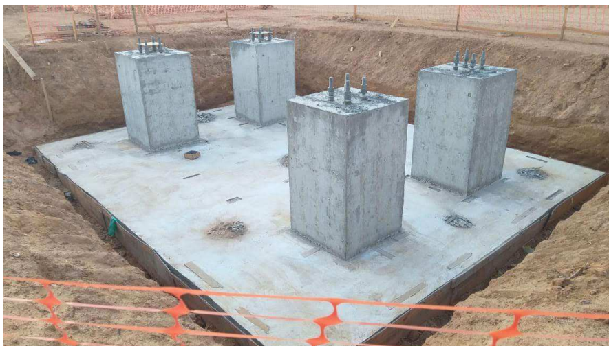
Figura 17 – Fundação de pórtico totalmente concretada.
