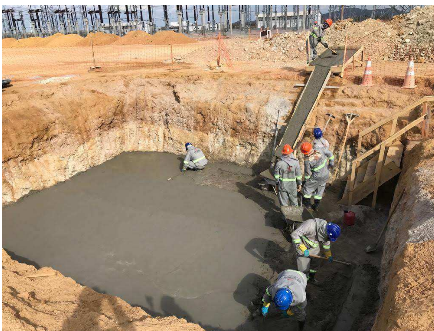
Figura 11 – Execução de concreto magro na fundação de um pórtico.
