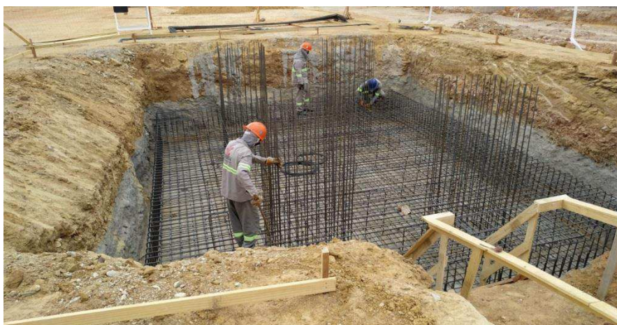
Figura 12 – Montagem da armadura da fundação de um pórtilco.
