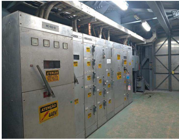
Figura 21: Sala elétrica 1 carregador de navios, a) CCM, b) painel com CLP e conversor.
