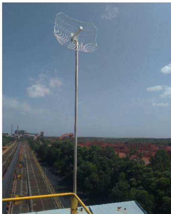
Figura 37: Rádio instalado na empilhadeira de carvão.
