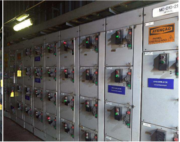
Figura 23: Sala elétrica descarregador de navios, a) painel de inversores, b) centro de motores, c) painel de relés, d) painel inversores (vista aproximada).
