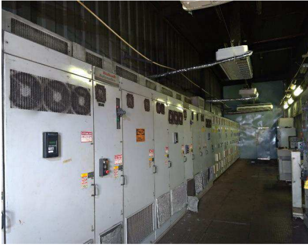
Figura 23: Sala elétrica descarregador de navios, a) painel de inversores, b) centro de motores, c) painel de relés, d) painel inversores (vista aproximada).
