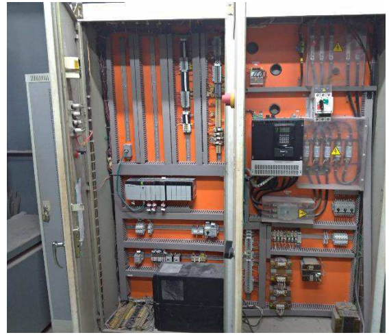
Figura 21: Sala elétrica 1 carregador de navios, a) CCM, b) painel com CLP e conversor.
