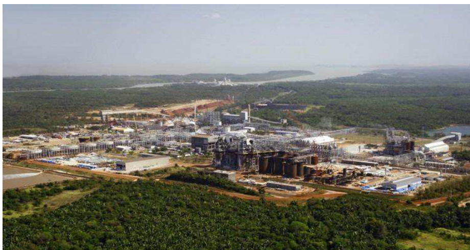
Figura 2 - Vista aérea da Refinaria da ALUMAR
