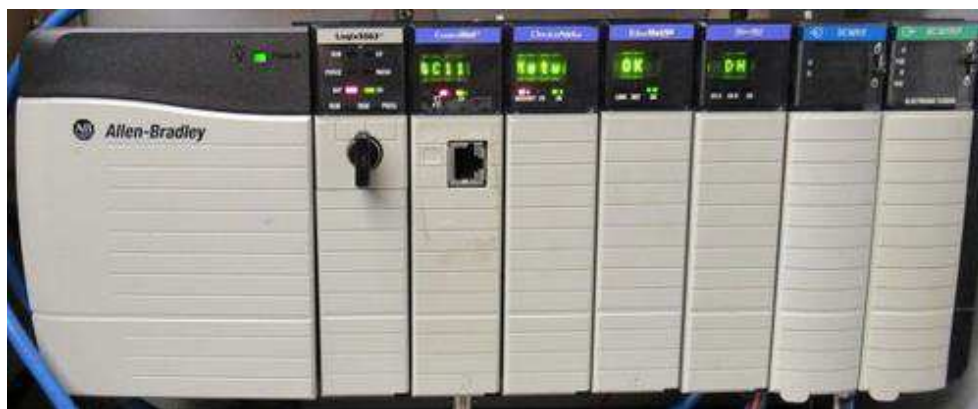
Figura 15 - PLC ControlLogix da Rockwell Automation , utilizado na substituição do PLC5 obsoleto.
