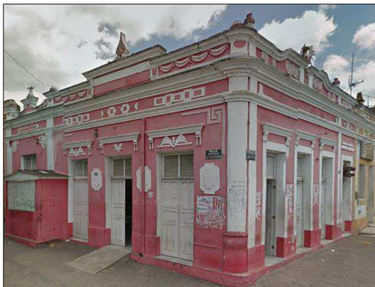
Biblioteca Epitácio Pessoa. Detalhe do edifício de cabeça de quadra. Ano 1942.
