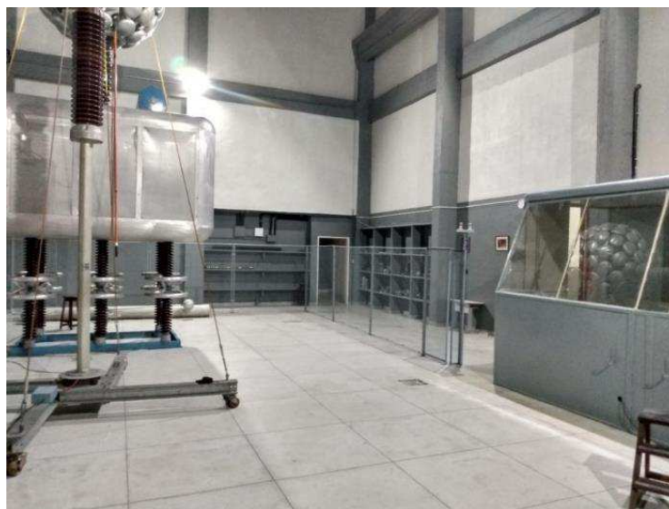
Figura 2 - Salão de alta tensão.
