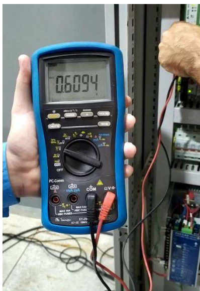
Figura 39 - Medição realizada no quadro de comando para comissionamento do kit da BHT.
