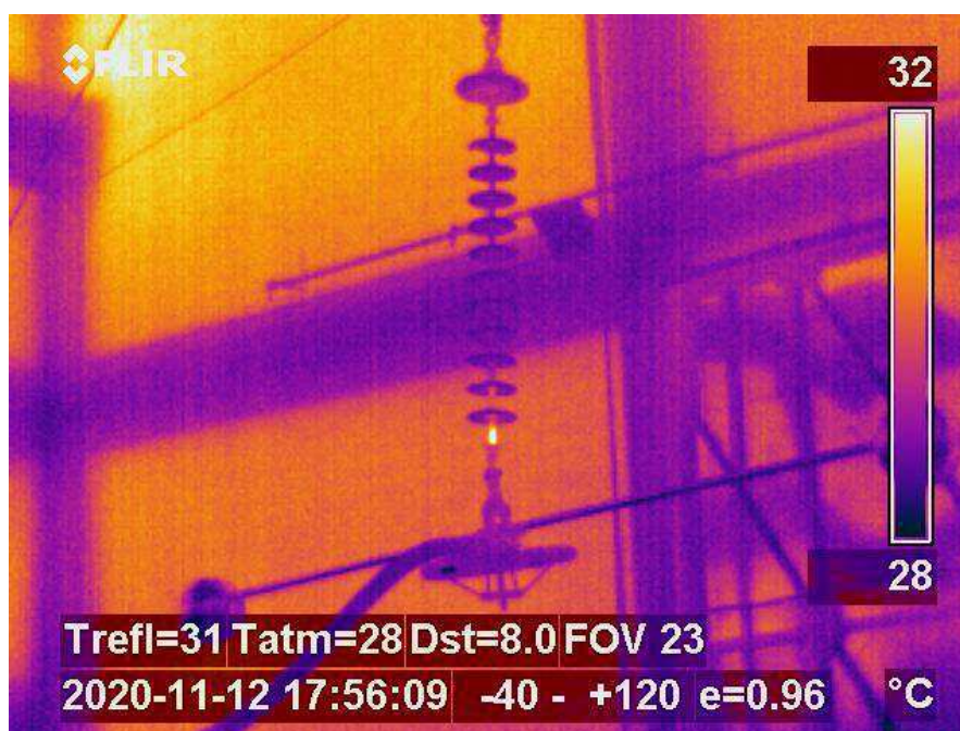
Figura 14 - Medição de temperatura de isolador por meio de termovisão.
