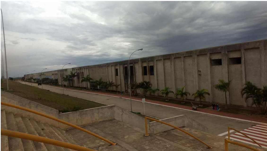
Figura 3 - Área externa da fábrica Wentex.
