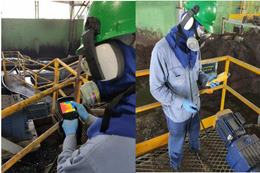
Figura 5 – Inspeção termográfica e análise de vibrações de um motor elétrico.
