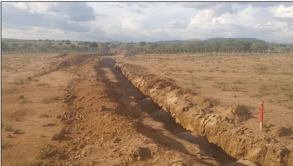
FIGURA 6 - CANALETAS ESCAVADAS EM PALMEIRA DOS ÍNDIOS – AL.
