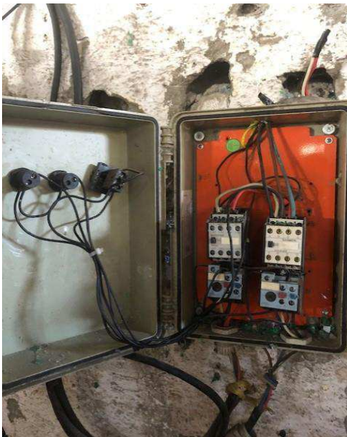
Figura 49: Interior do quadro após a reorganização Fonte: Autoria própria
