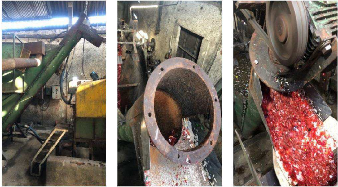
Figura 43: Tanque antes, durante e depois da manutenção respectivamente Fonte: Autoria própria
