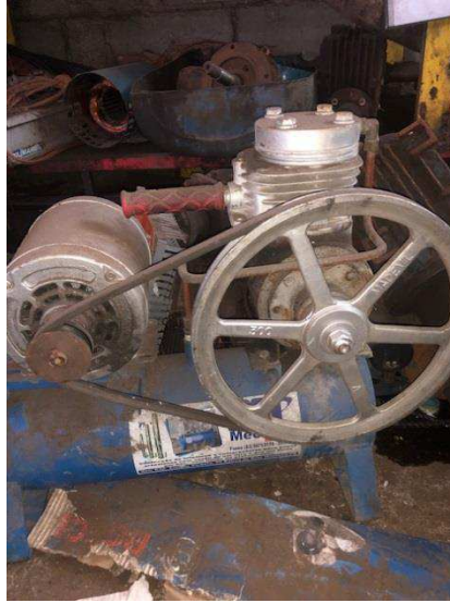
Figura 54: Compressor quebrado utilizado anteriormente para o poço. Fonte: Autoria própria
