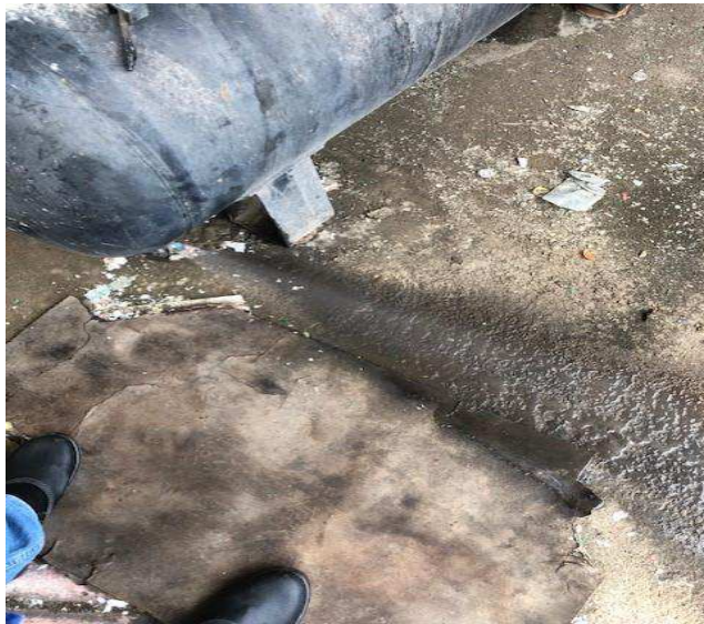
Figura 21: Estagiário realizando a purga no compressor Fonte: Autoria própria
