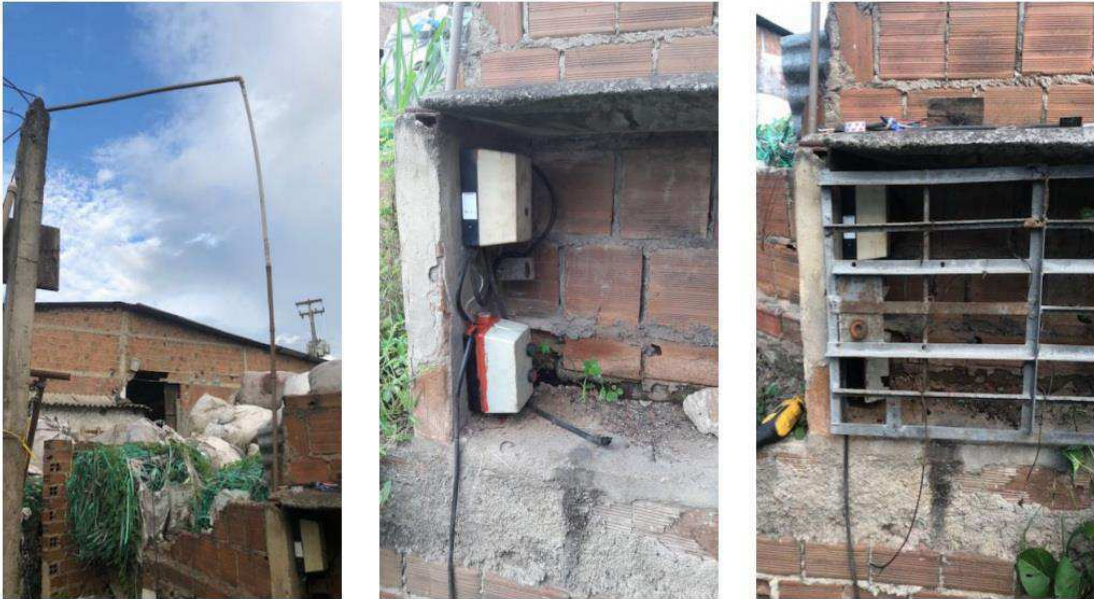
Figura 17: Comando da bomba d'água após as modificações em local abrigado. Fonte: Autoria Própria
