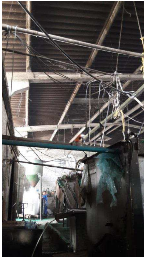
Figuras 08 e 09: Instalações elétricas inadequadas Fonte: Autoria própria
