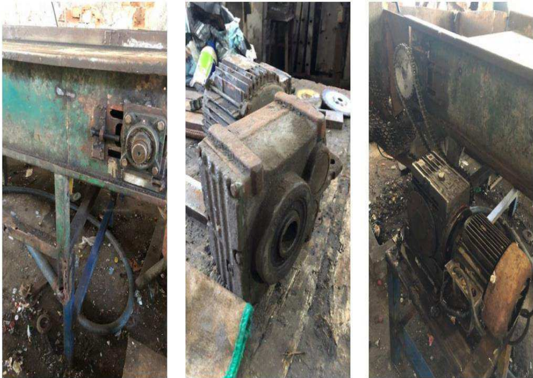
Figura 24: Local onde o motor estava, conjunto motor/redutor, motor instalado no novo local respectivamente.
