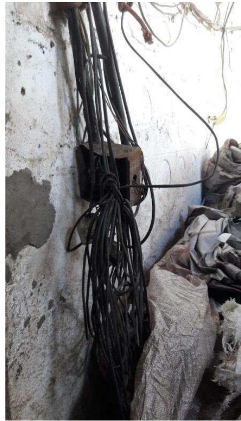
Figuras 08 e 09: Instalações elétricas inadequadas Fonte: Autoria própria
