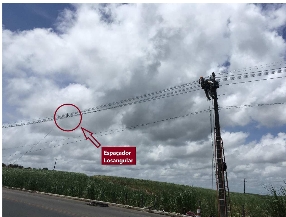
Figura 45 – Instalação de espaçador losangular.
