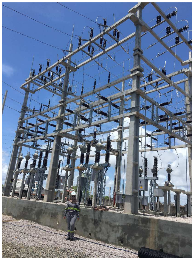
Figura 40 – Utilização dos EPIs para acompanhamento da obra.
