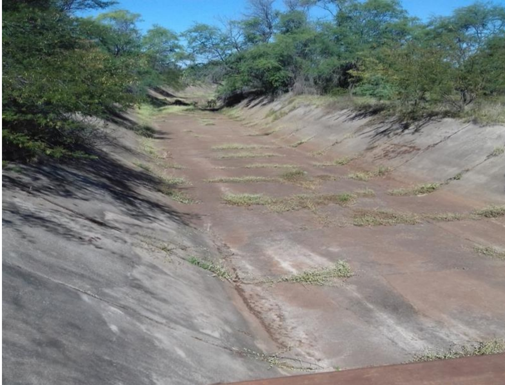
Foto 17 – Canal de Alívio
