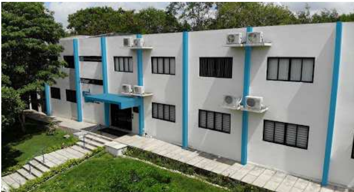
Figura 1 – Fotografia da Fachada do Laboratório Embedded
