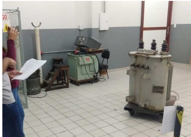
Figura 18 - Bastidor da gravação da vídeo aula de ensaio em transformadores.
