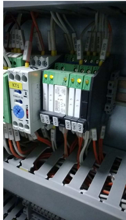
(b) Contator KA21 substituído.
