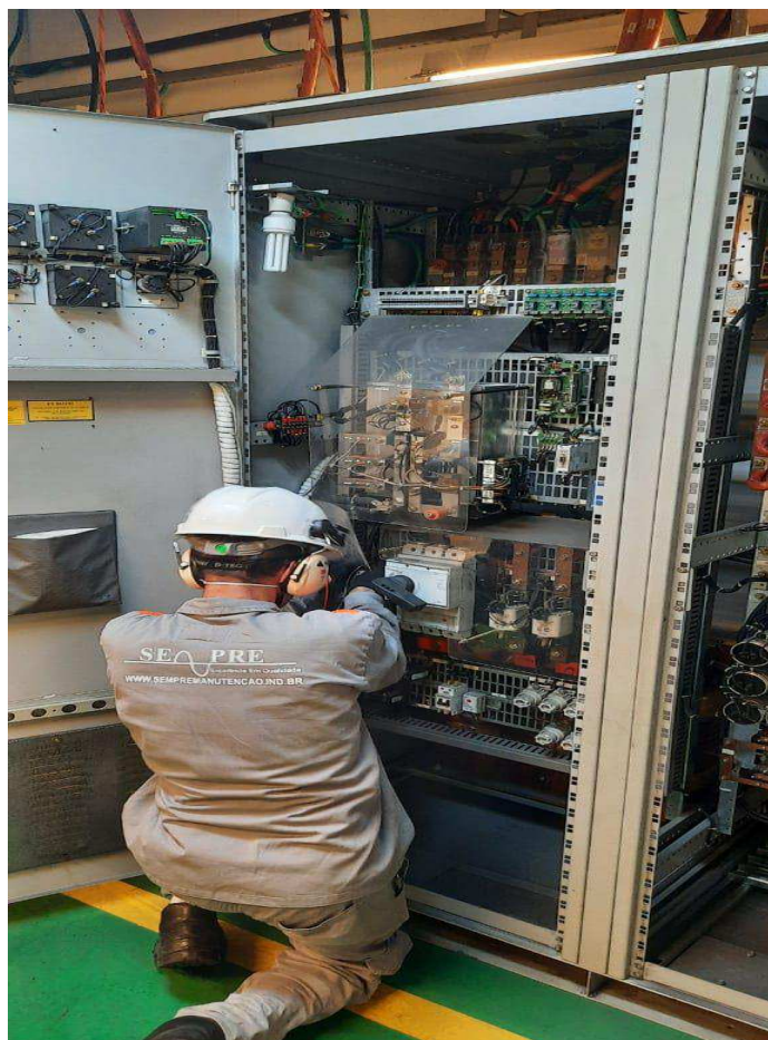
Figura 6 - Atividade de Manutenção em Retificadores
