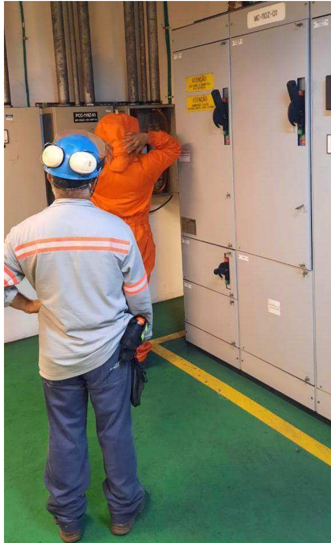
Figura 7 – EBTV para Atividade de Manutenção em Retificadores
