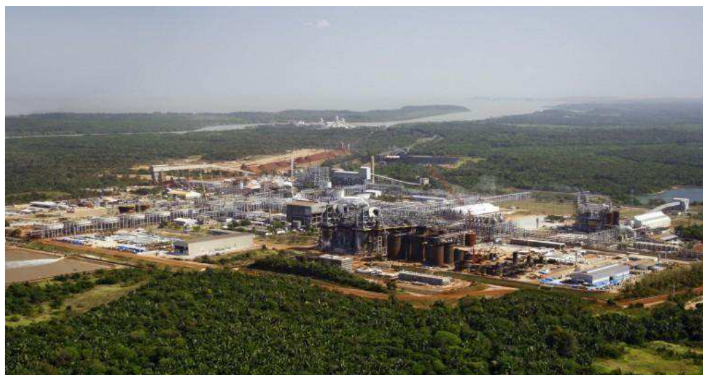
Figura 2 - Vista aérea da Refinaria da ALUMAR
