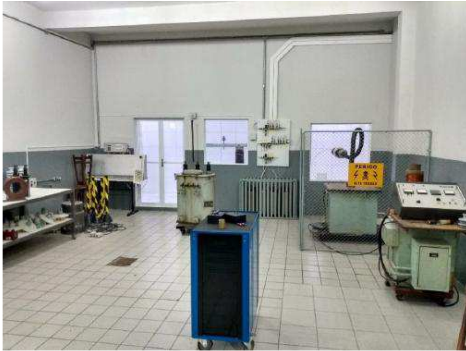
Figura 3: Sala da Câmara de Névoa.
