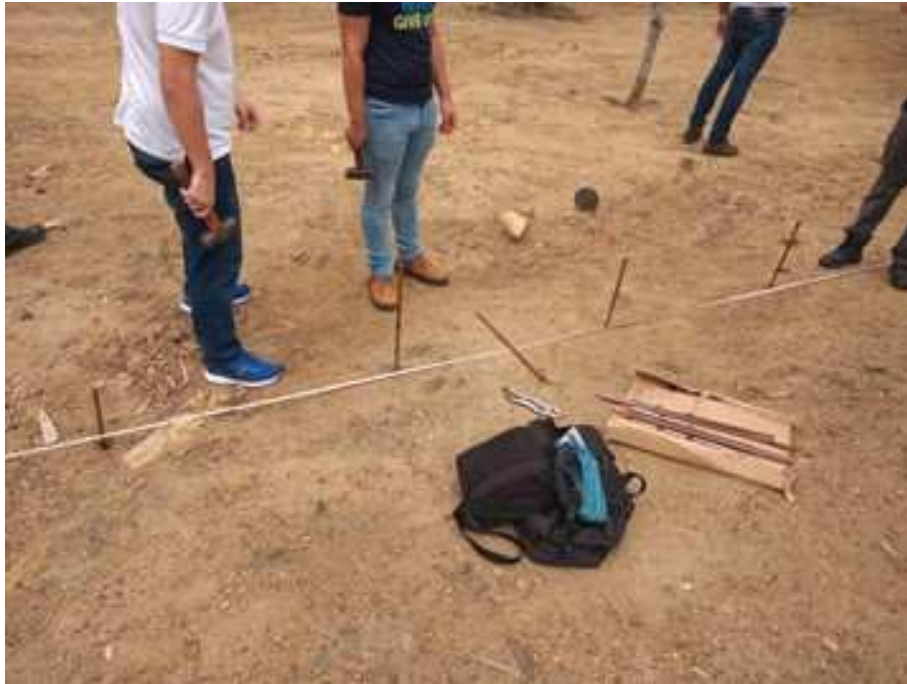
Figura 17: fixação das hastes.
