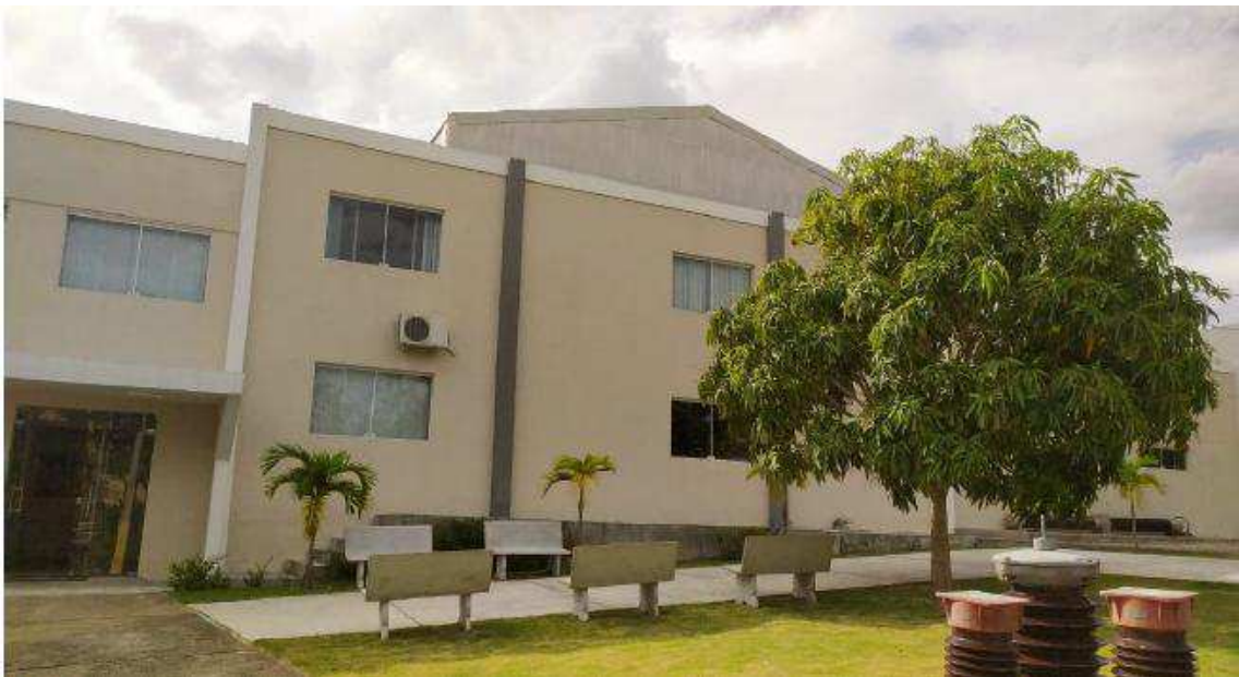
Figura 1: Entrada principal do Laboratório de Alta Tensão.
