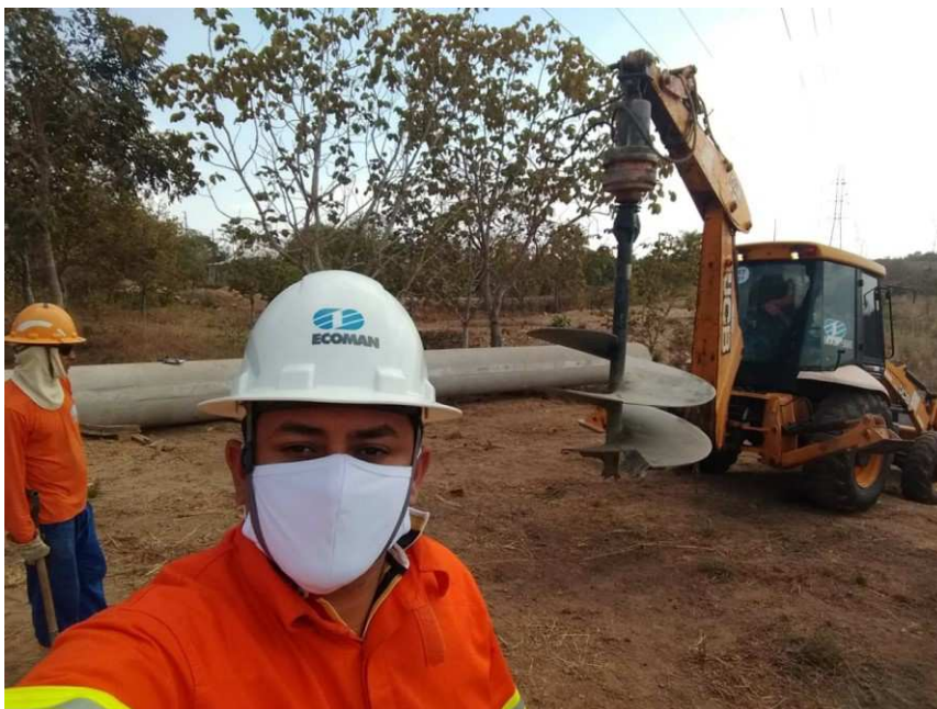
Figura 21 Trado Utilizada para Escavação
