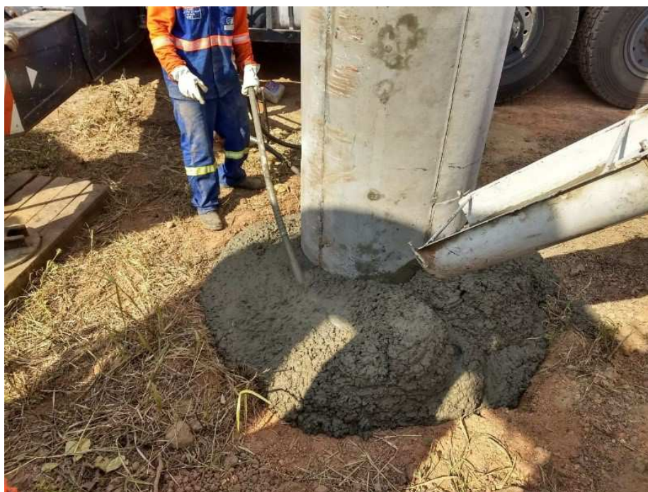
Figura 25 Concretagem de Estrutura
