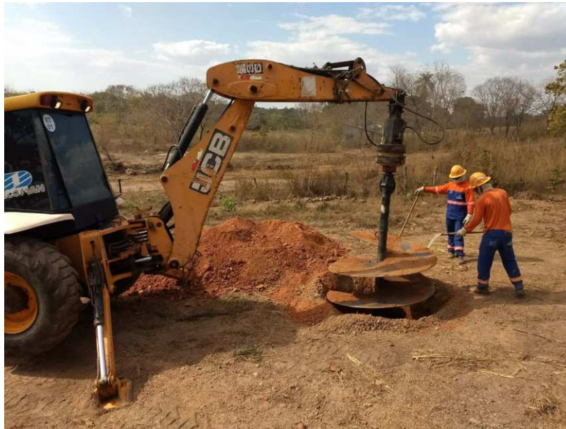
Figura 20 Escavação para Fundação de Poste
