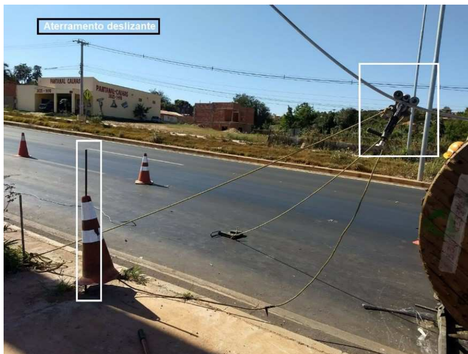
Figura 27 Aterramento Deslizante
