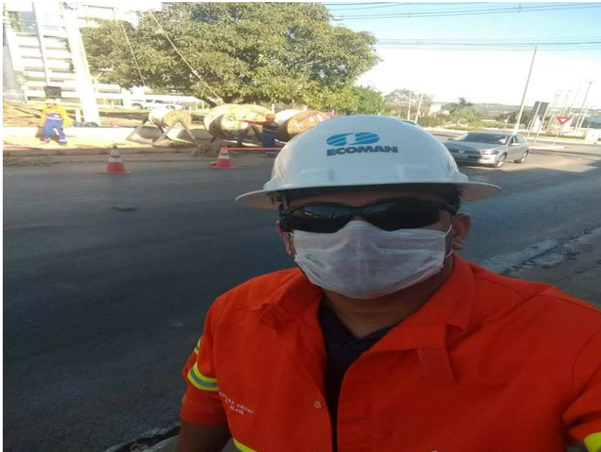
Figura 28 Lançamento de Cabos
