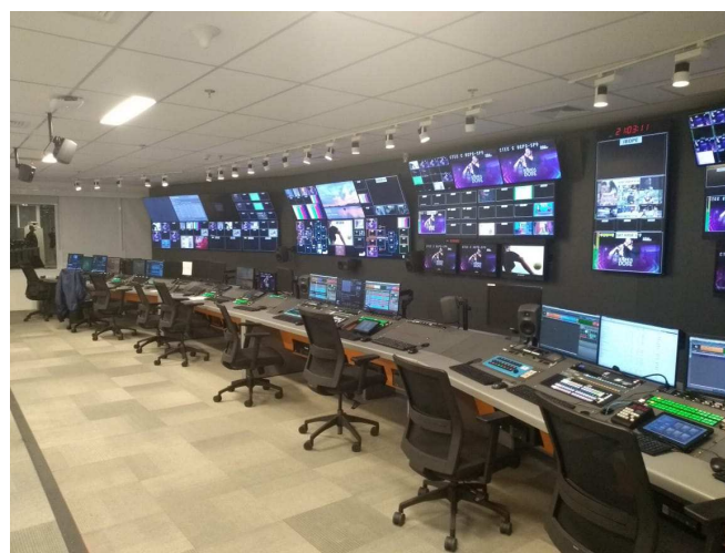
Figura 2.5 – Fotografia do Centro de Exibição e Distribuição da Globo-SP.
