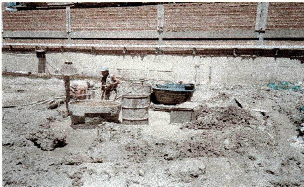
Figura 2.21 - Depósito local de lama bentonítica para reaproveitamento.
