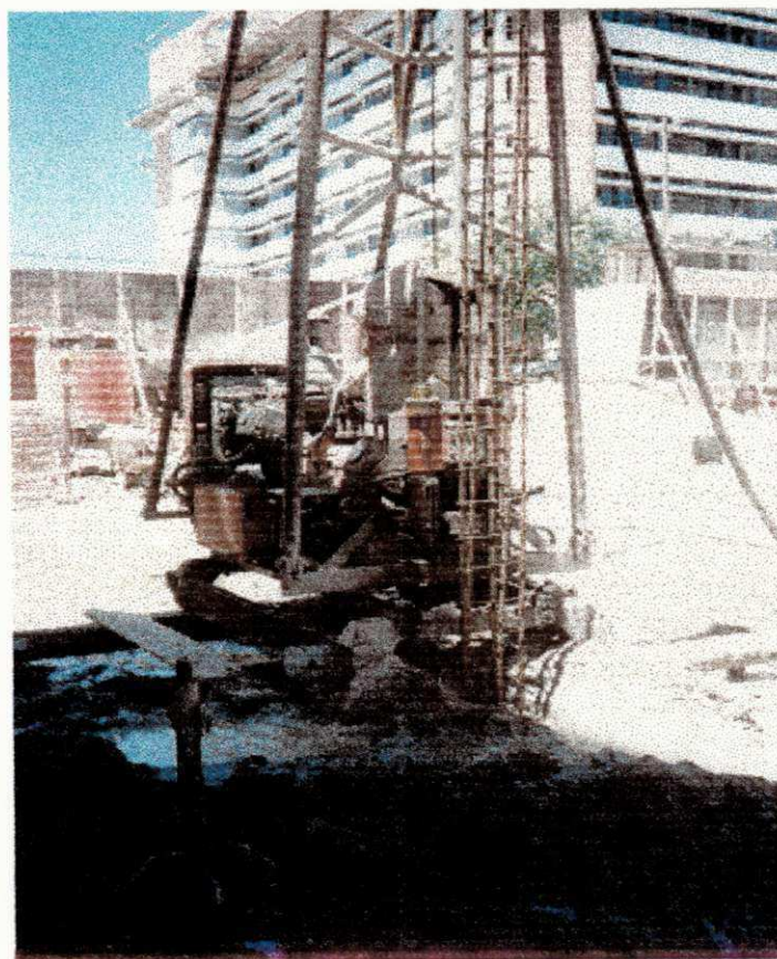
Figura 2.22 - Colocação da armadura.
