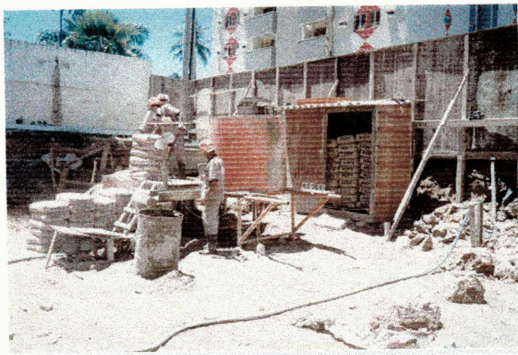
Figura 2.24 - Usina de argamassa.
