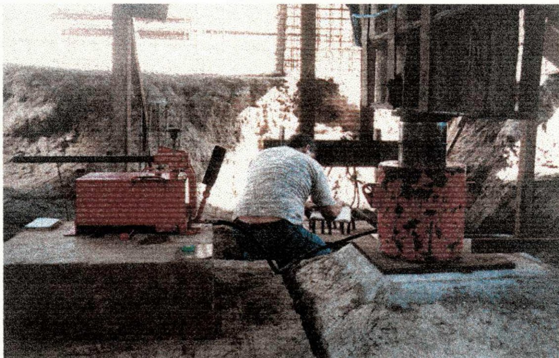
Figura 3.7 - Vista da bomba e do macaco no momento da aplicação da carga.
