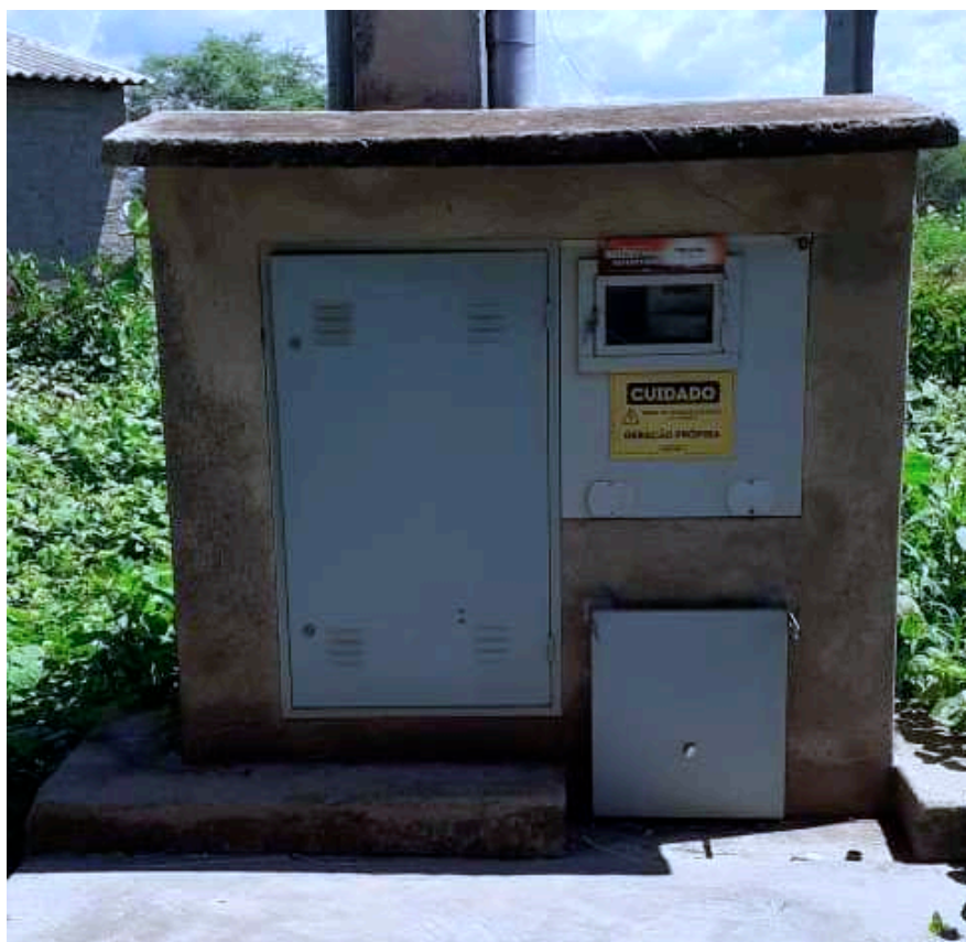
Figura 3.13 – Registro fotográfico do padrão de medição de energia elétrica da Cerâmica Irmãos Rolim.
