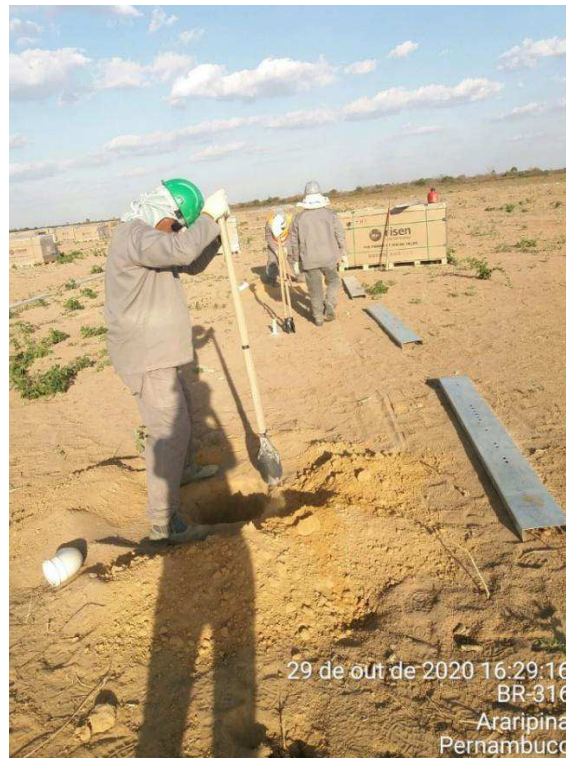
Figura 22: Escavação dos pontos marcados.
