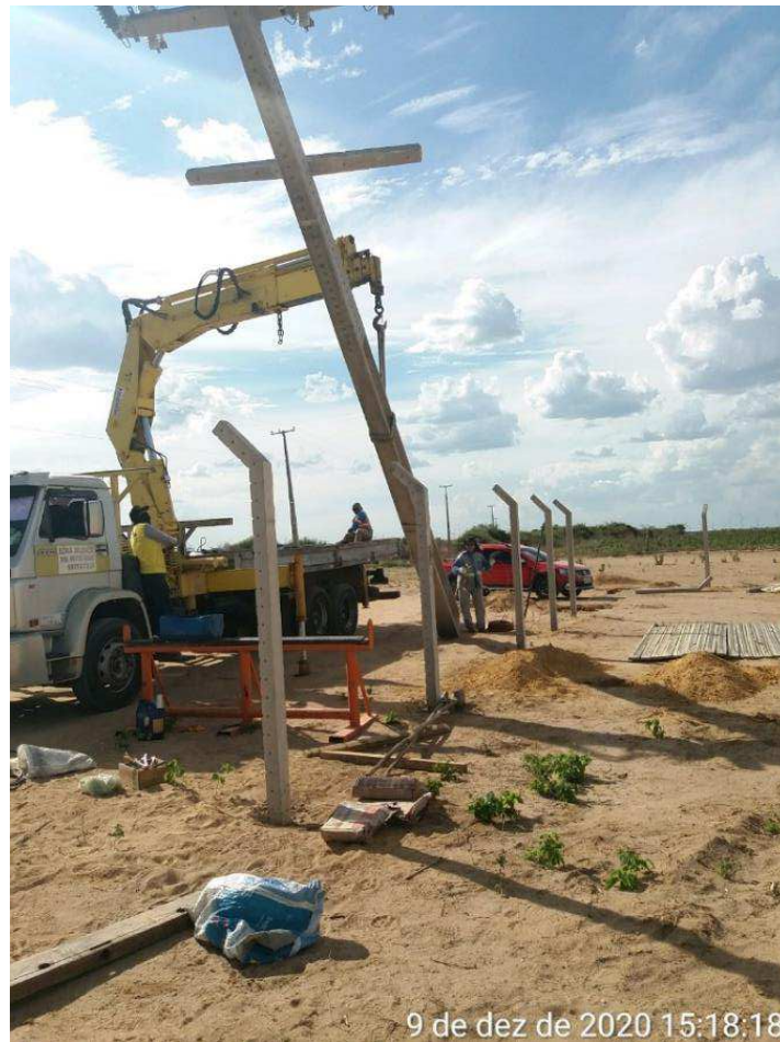
Figura 20: Alocação do poste.
