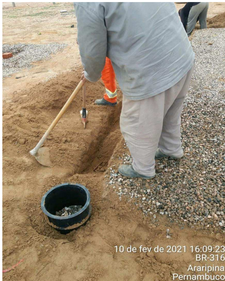
Figura 8: Execução de ligação equipotencial do aterramento.
