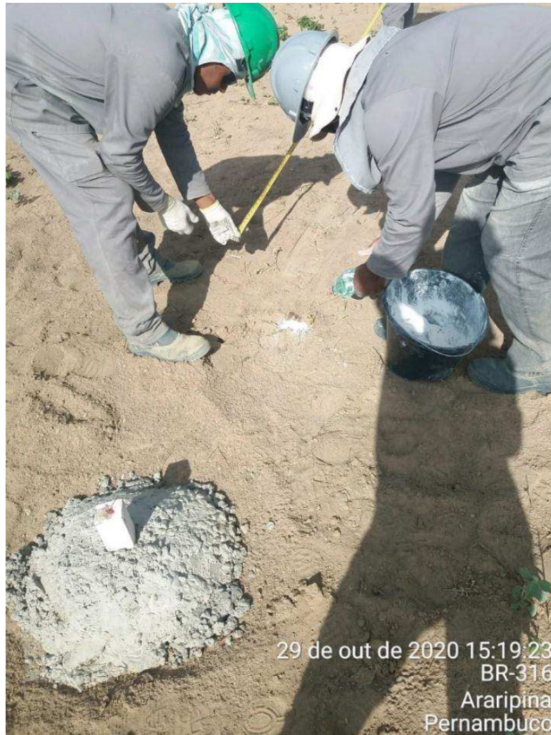
Figura 21: Demarcação dos pontos a serem cavados para instalação das estruturas metálicas.
