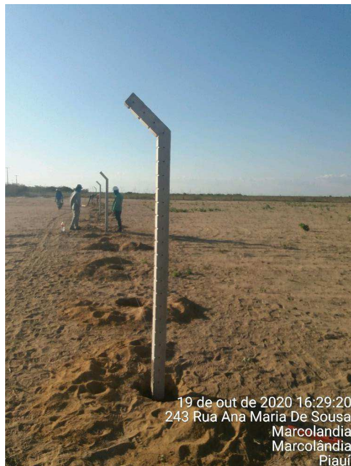
Figura 4: Instalação da cerca que delimita a usina.
