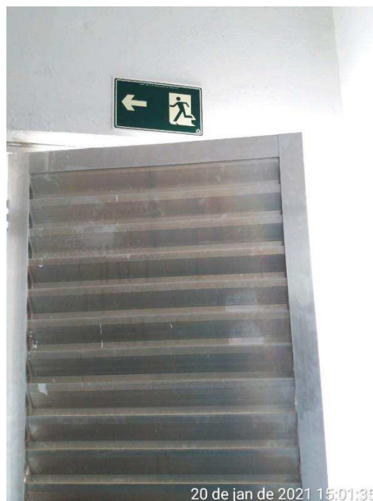
Figura 24: Placa de sinalização de saída de emergência na sala de controle da usina.
