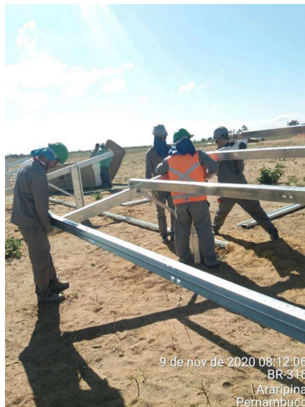
Figura 23: Montagem das mesas para receber os módulos.
