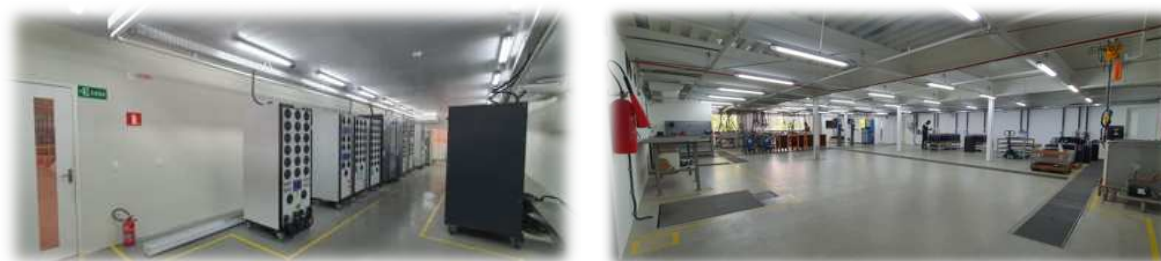
Figura 56 – Obra de Construção da Sala do Laboratório Físico
