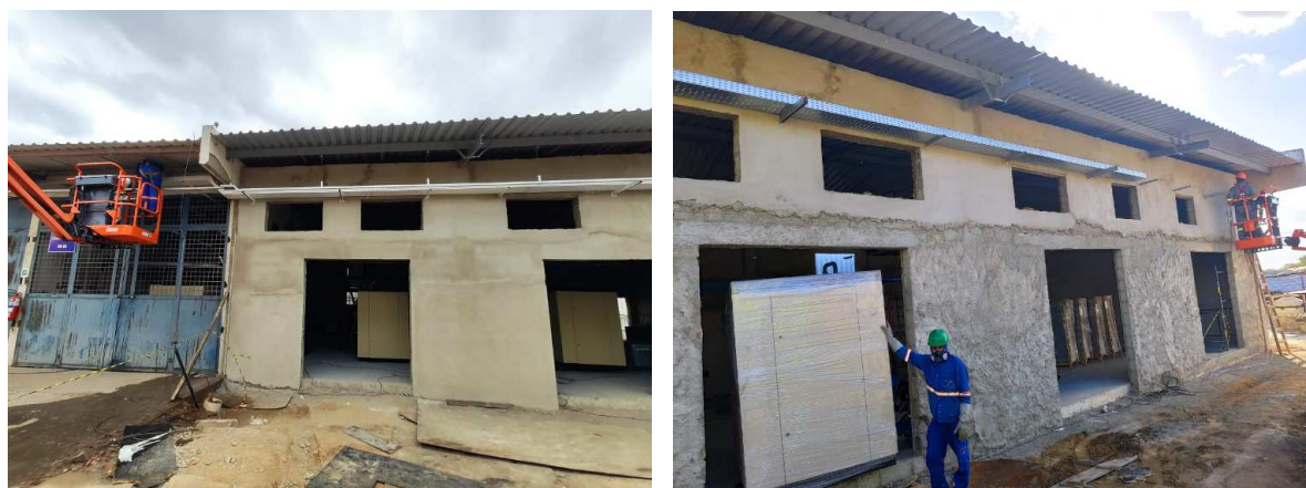
Figura 52 – Obra de Construção da Sala de Ar Comprimido
