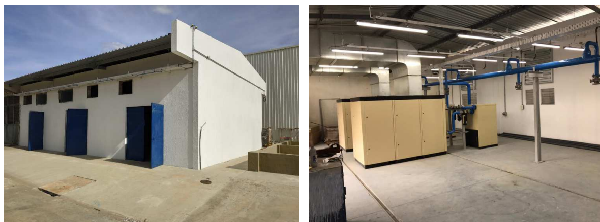
Figura 54 – Obra de Construção da Sala de Ar Comprimido
