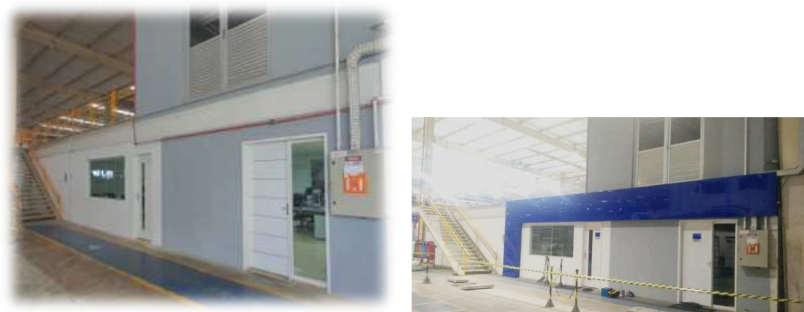
Figura 57 – Obra de Construção da Sala do Laboratório Físico Antes/Depois
