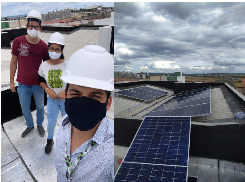
Figura 20 – Visita técnica e instalação de módulos
