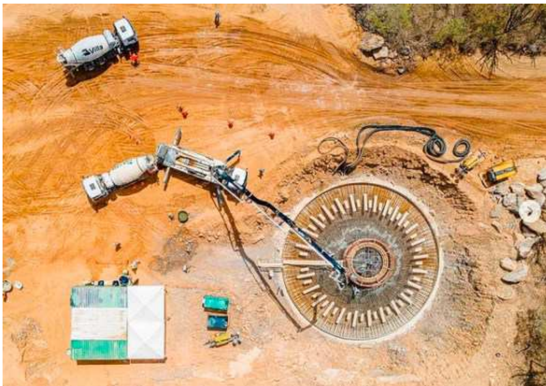
Figura 22: Concretagem das bases dos aerogeradores do Complexo Rio do Vento.
