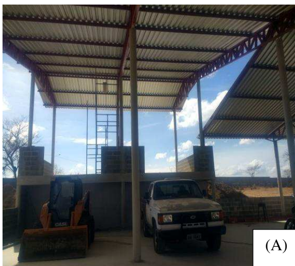
(A) Galpão de triagem da fase de construção
