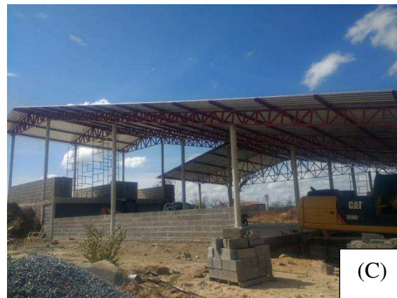
(C) Galpão de triagem finalizado
