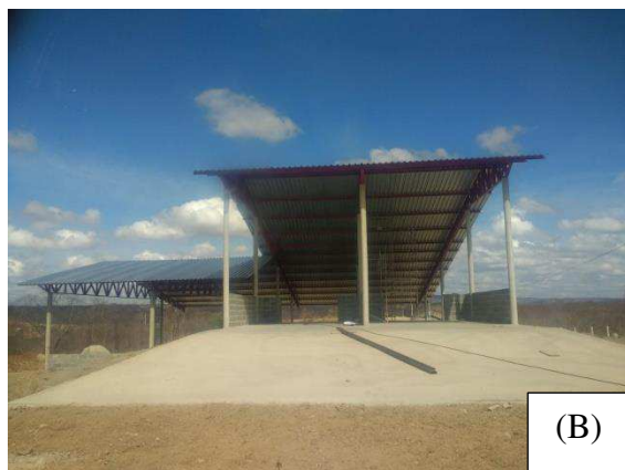
(B) Rampa de descarga
