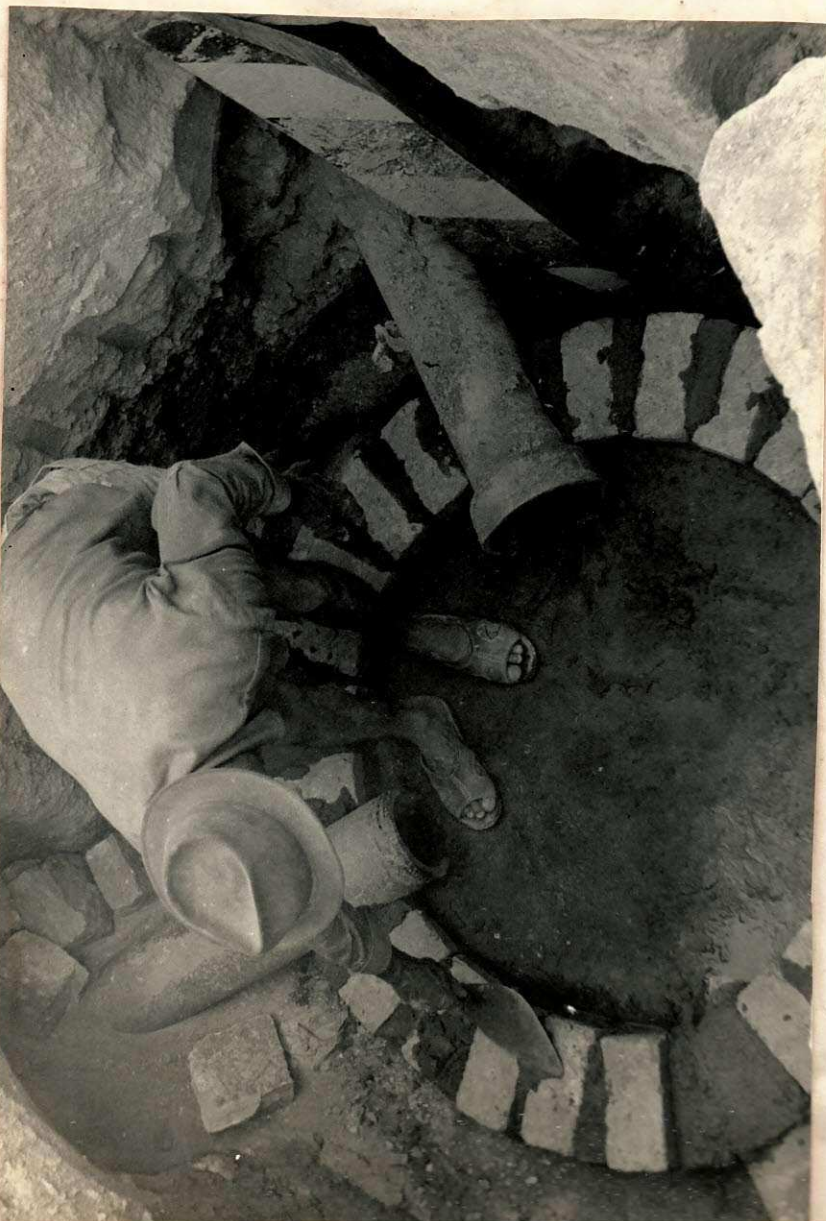
-BASE DO POÇO - APARECENDO AS EN- TRADAS DA MANILHA
