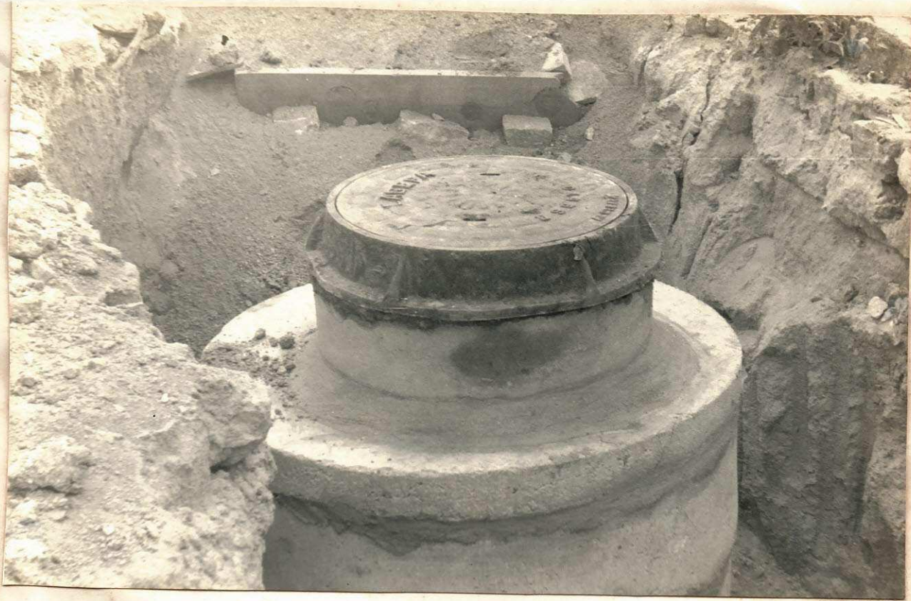
POÇO - DE - VISITA EXECUTADO
