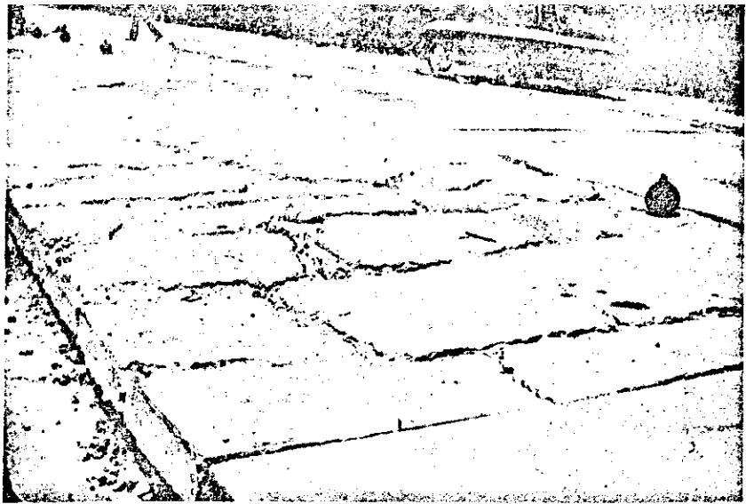
Desintegração total de um trecho de um pavimento de concreto de cimento.
