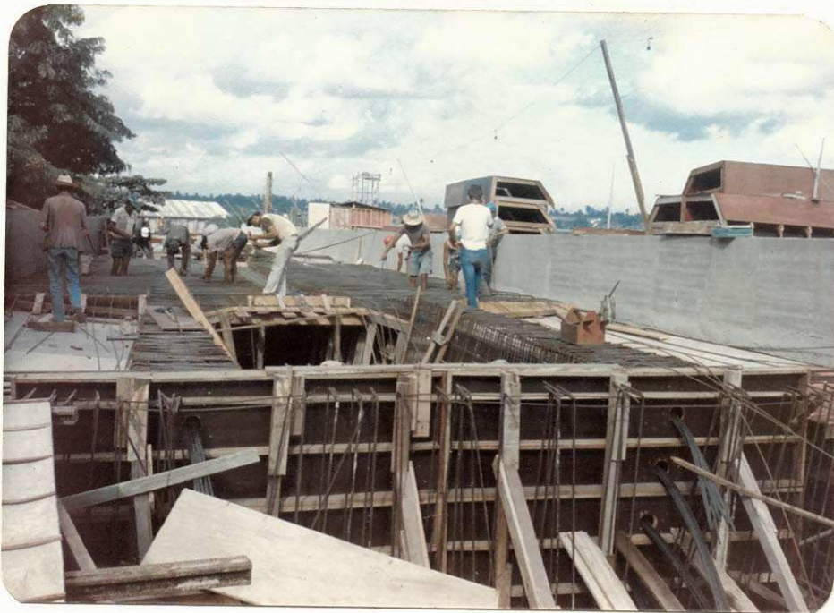
Ferragem da laje superior e vigas principais para serem concretadas. Detalhe dos cabos de aço da protensão antes de serem tracionados.
