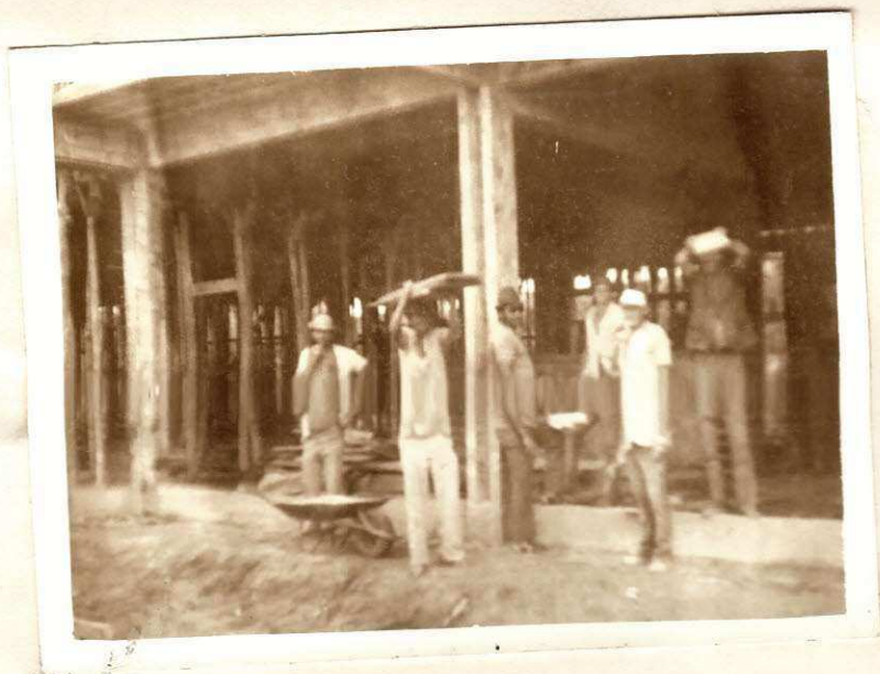
Pedreiros, Serventês e Mestre de Obra ✓
