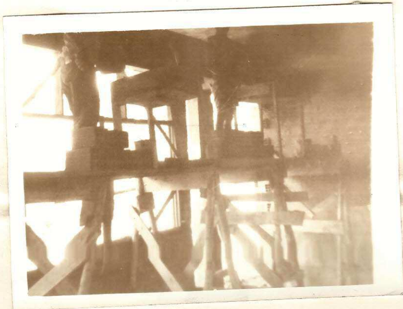
Andaime interno - Revestimento do Refeitório ✓
