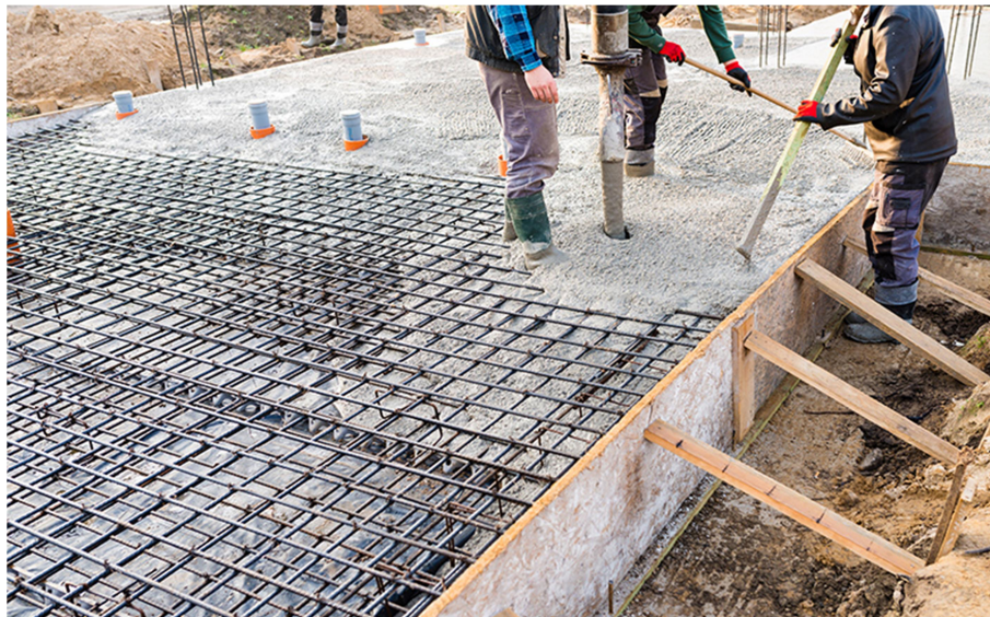
Figura 3 - Concretagem de estrutura em concreto armado
