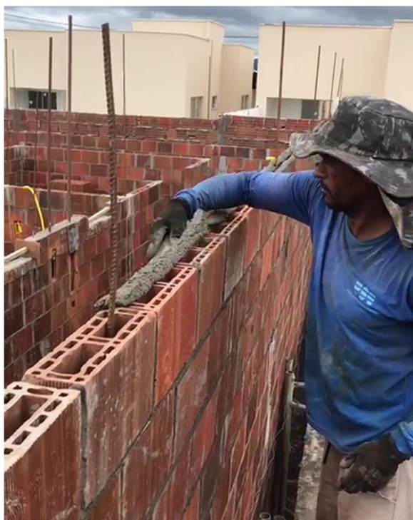
Figura 4 - Execução de alvenaria estrutural
