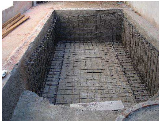
Figura 1 – Reservatório enterrado (piscina)
