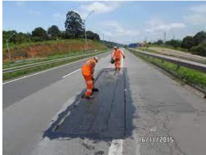
Figura 13- Demonstração de remendo no pavimento.
