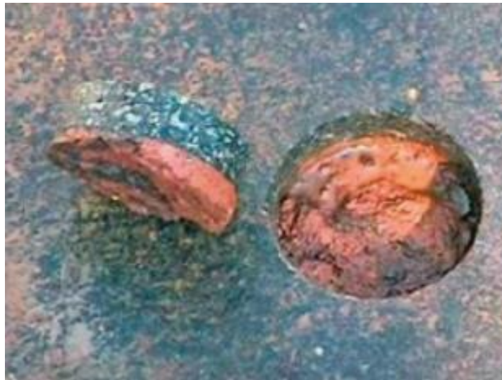
Figura 14- Remoção de corpo de prova.
