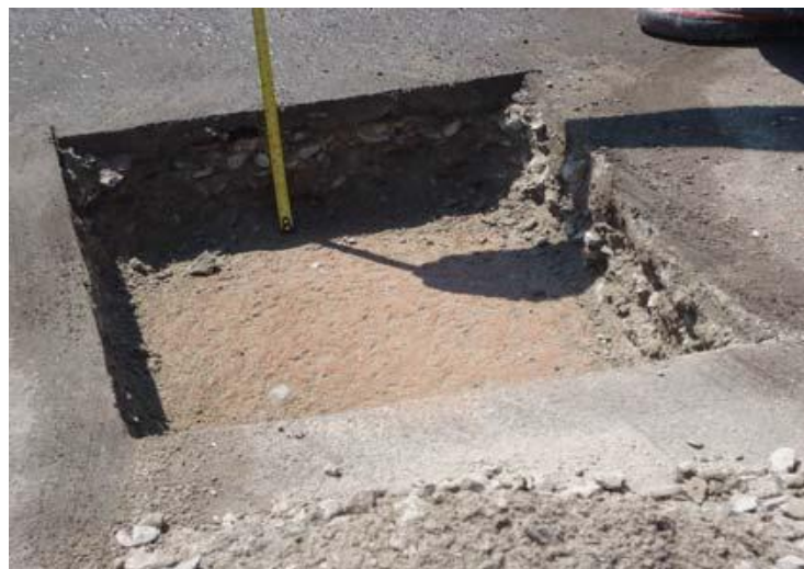
Figura 15- Abertura de poço de inspeção para investigação do solo.
