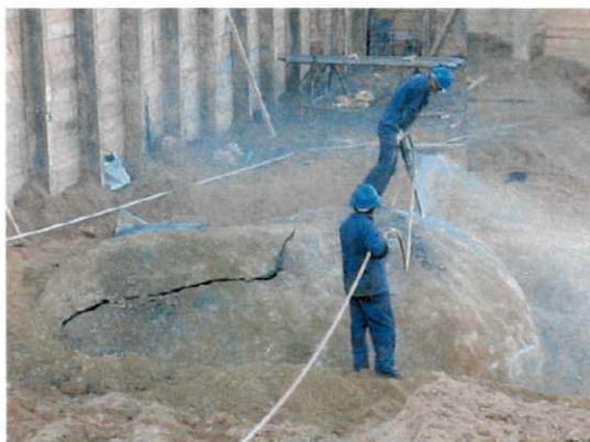
Figura 5 - Execução de furos na rocha com martelete hidráulico (ARAUJO NETO, 2006).
