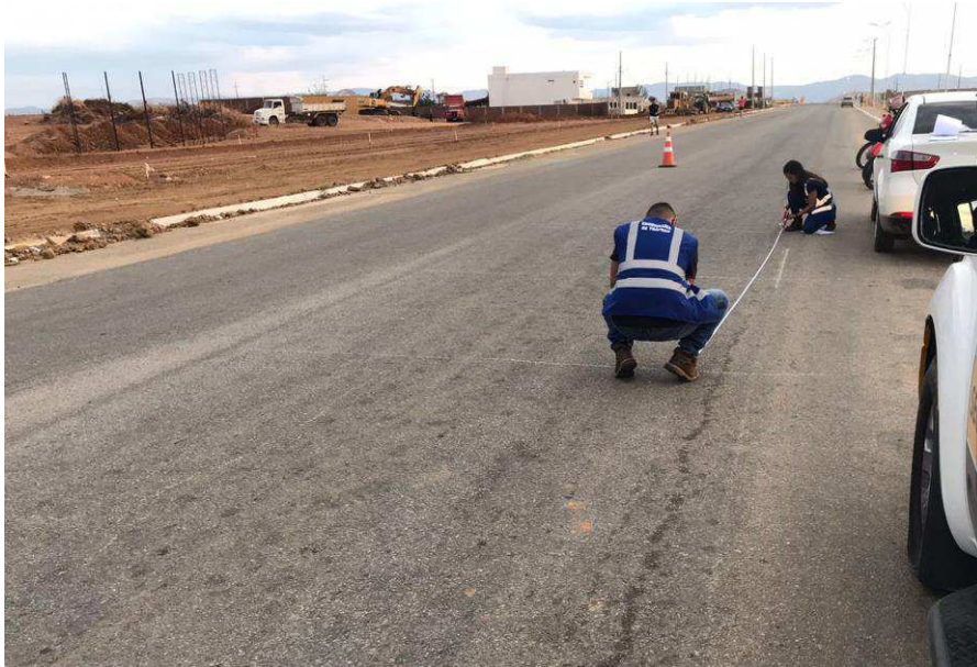
Figura 20 – Marcação de estação e superfície de avaliação
